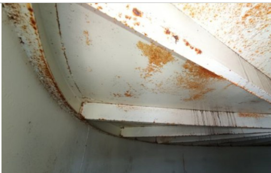
RJ ITA – Corrosão no teto
