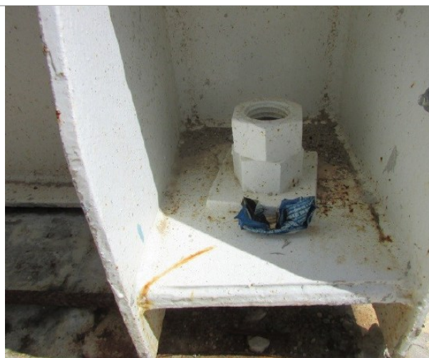
CE 1 – Ponto de corrosão na ancoragem
