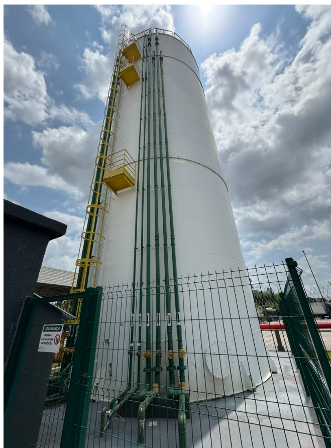
Figura 1 - Imagem de reservatório metálico tipo cilíndrico.
