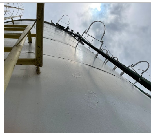
BA 1 – Deformação das chapas do costado
