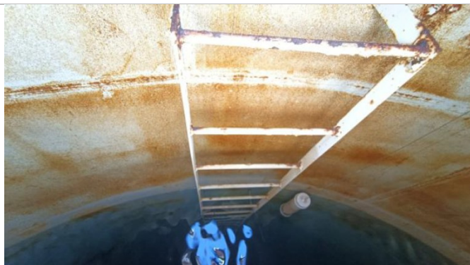
CE 1 - Corrosão severa uniforme e generalizada no costado e escada
