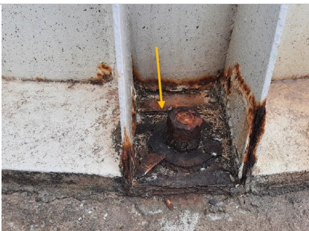
CE 1 – Corrosão avançada na ancoragem
