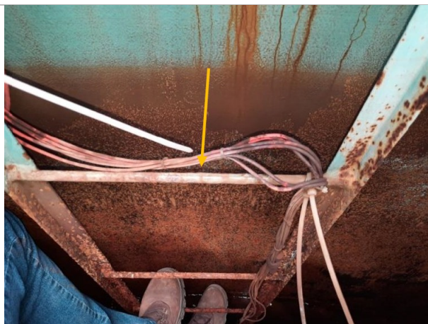
CE 1 - Corrosão severa uniforme e generalizada no costado e escada
