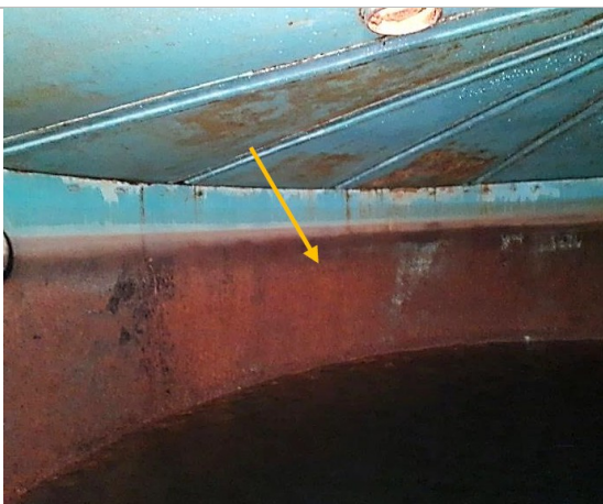
CE 1 – Corrosão severa uniforme e generalizada no costado
