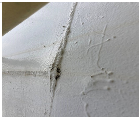
AL – Deformação em chapas do costado
