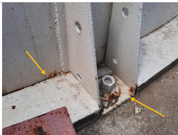
CE 1 – Ponto de corrosão na ancoragem
