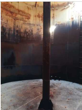
RJ ITA – Corrosão no teto
