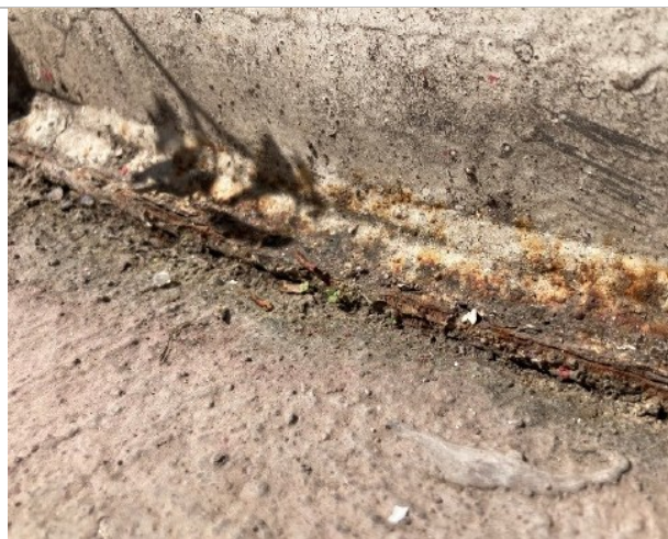
SP 1- Pontos de corrosão na chapa da base
