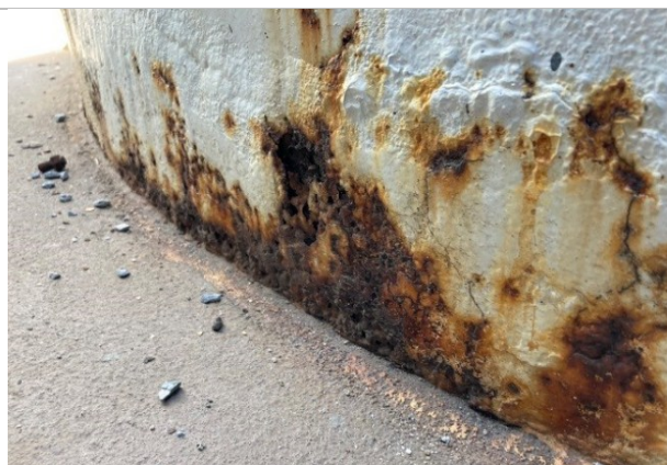
SP 1- Pontos de corrosão na chapa da base
