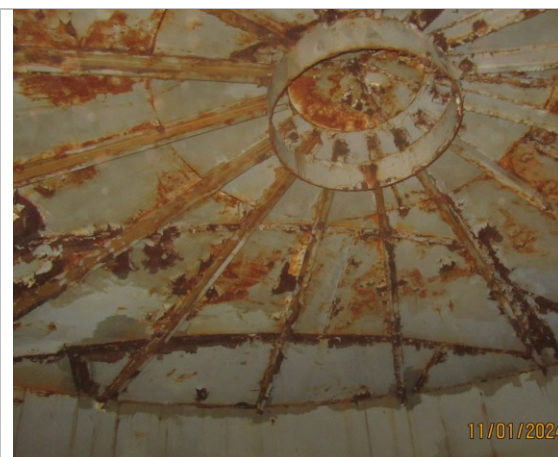
ES 1 – Corrosão generalizada no pilar central apoio no fundo do castelo
