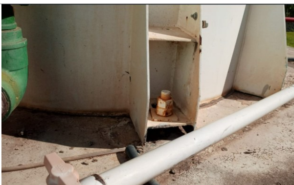
ES 1 – Pontos de corrosão na base e nichos de ancoragem
