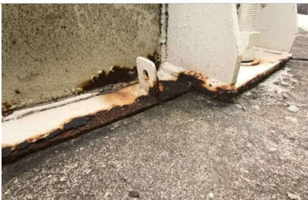
ES 1 – Pontos de corrosão na base e nichos de ancoragem
