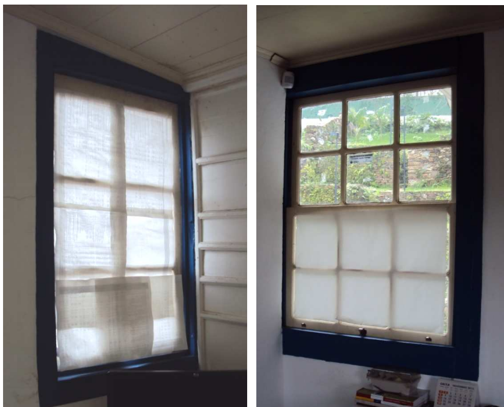
Figura 65: Vista de duas janelas do Segundo Pavimento onde os usuários bloquearam a incidência da insolação através da fixação de folhas de papel sobre os vidros. Fonte: Acervo pessoal do autor, nov. 2015.
