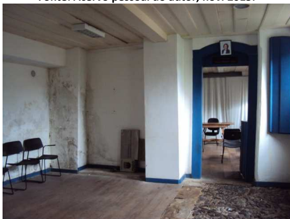
Figura 25: Vista parcial do ambiente de entrada do pavimento térreo do Casarão Rocha Lagoa, que hoje funciona como depósito de materiais. Fonte: Acervo pessoal do autor, nov. 2015.
