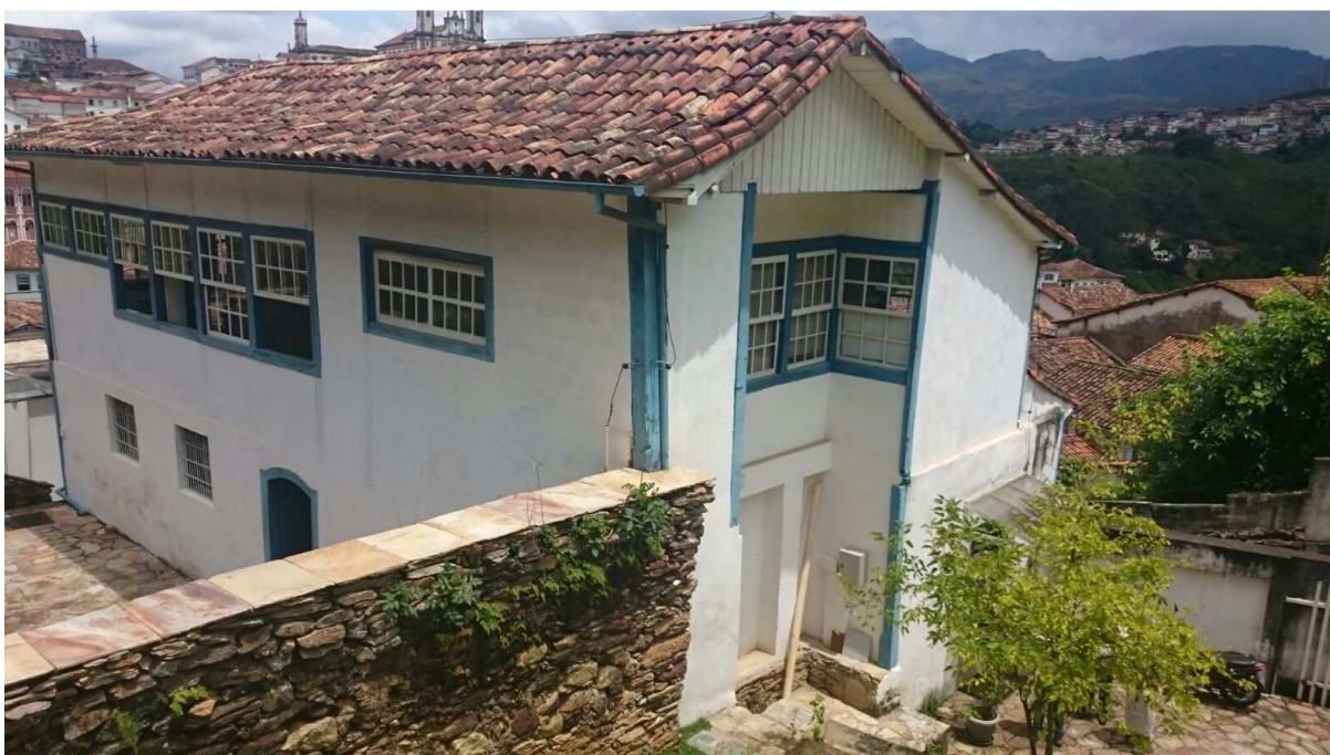
Figura 19: Vista parcial das fachadas lateral direita e posterior do Casarão Rocha Lagoa. Fonte: Acervo pessoal do autor, nov. 2015.
