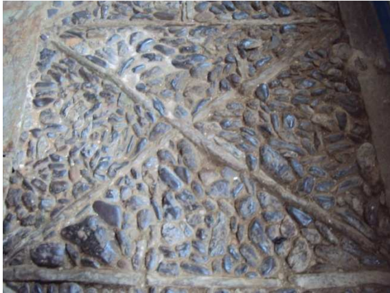
Figura 27: Detalhe do piso em pedra fincada existente no pavimento térreo. Fonte: Acervo pessoal do autor, nov. 2015.
