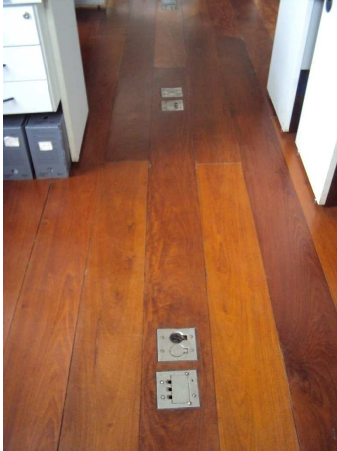
Figura 71: Neste ambiente, em função do layout interno, as tomadas ficaram localizadas no corredor entre as estações de trabalho. Fonte: Acervo pessoal do autor, nov. 2015.
