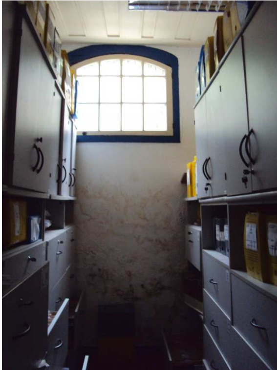
Figura 39: Vista parcial do Arquivo localizado no primeiro pavimento. Fonte: Acervo pessoal do autor, nov. 2015.
