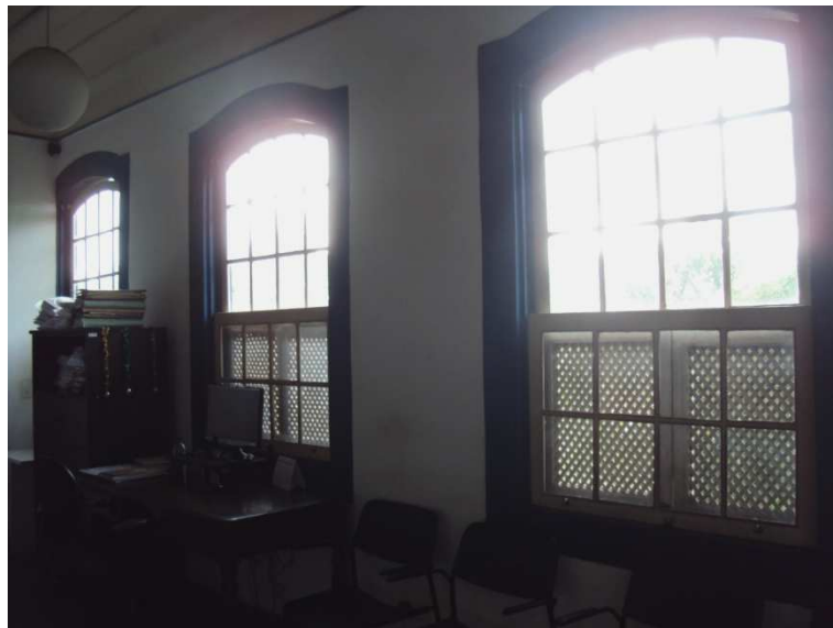
Figura 58: Vista interna de um ambiente localizado no Primeiro Pavimento do Casarão Rocha Lagoa, onde se observa os muxarabiês nas janelas. Fonte: Acervo pessoal do autor, nov. 2015
