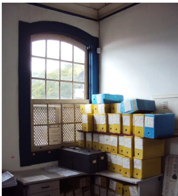
Figura 67: Exemplo de janela localizada no Primeiro Pavimento que, em função da alta velocidade que o vento entra no ambiente, permanece constantemente fechada, assim como seu muxarabê, provocando uma constante área de sombreamento. Fonte: Acervo pessoal do autor, nov. 2015.
