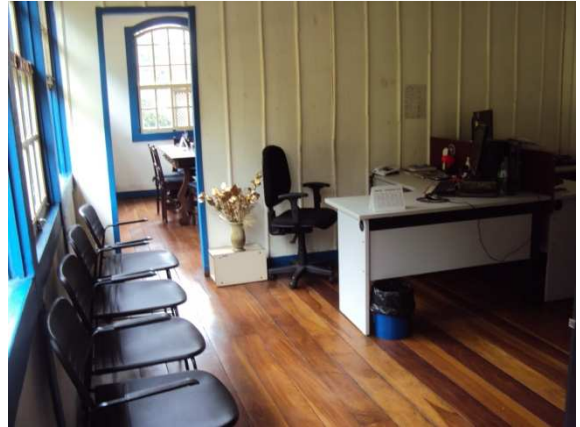
Figura 44: Vista parcial da recepção do segundo andar, onde é possível observar o sistema construtivo taquibe das alvenarias. Fonte: Acervo pessoal do autor, nov. 2015.
