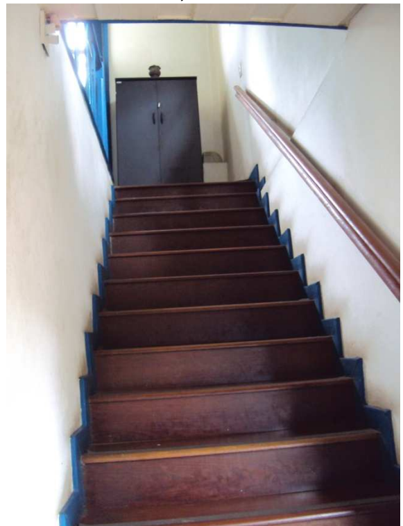
Figura 42: Vista da escada que dá acesso do primeiro para o segundo pavimento. Fonte: Acervo pessoal do autor, nov. 2015.
