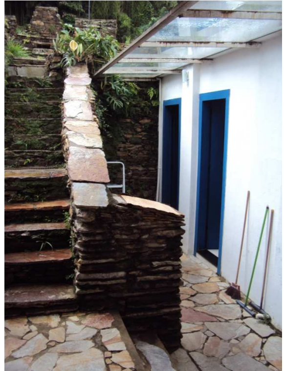
Figura 40: Vista da área externa do primeiro pavimento que dá acesso ao anexo construído em 2010 que abriga dois banheiros e uma cozinha. Fonte: Acervo pessoal do autor, nov. 2015.
