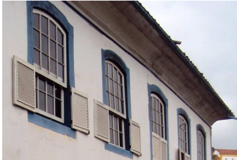
Figura 57: Vista parcial da fachada frontal do Casarão Rocha Lagoa onde se observa os muxarabiês das janelas. Fonte: Acervo pessoal do autor, nov. 2015.
