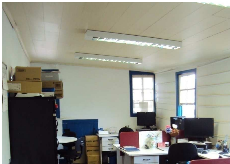
Figura 75: Vista parcial de um ambiente localizado no Segundo Andar onde é possível observar a distribuição das luminárias sobre as estações de trabalho. Fonte: Acervo pessoal do autor, nov. 2015.
