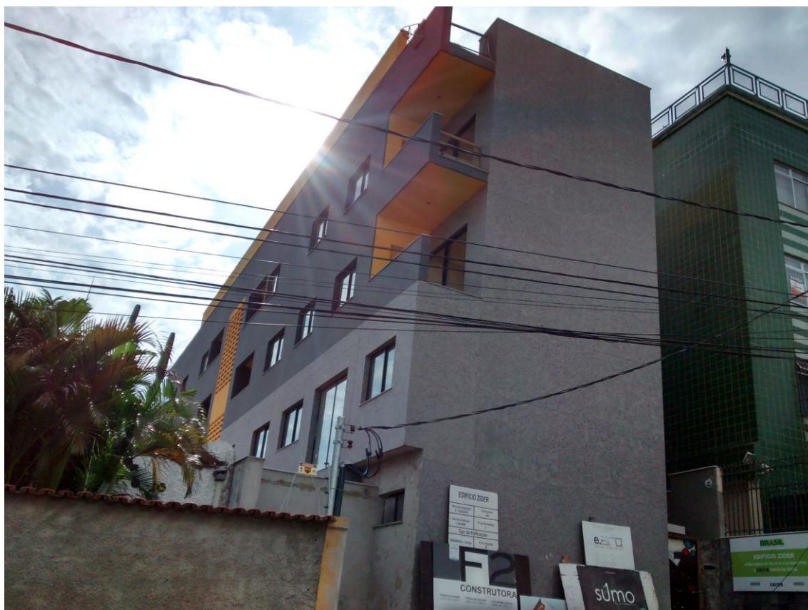
Figura 31 – Foto Edifício Zider, ainda em construção, acervo pessoal.
