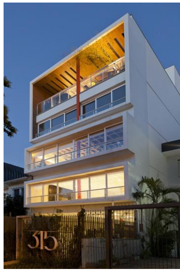
Figura 6 – Edifício Amélia Teles 315 da incorporadora Smart!
