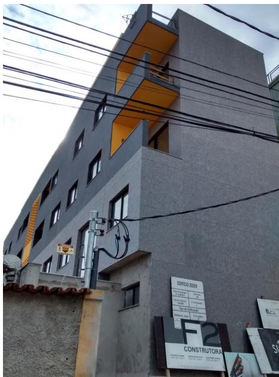
Figura 11 - Edifício Zider – Grupo Sumo - 2011
