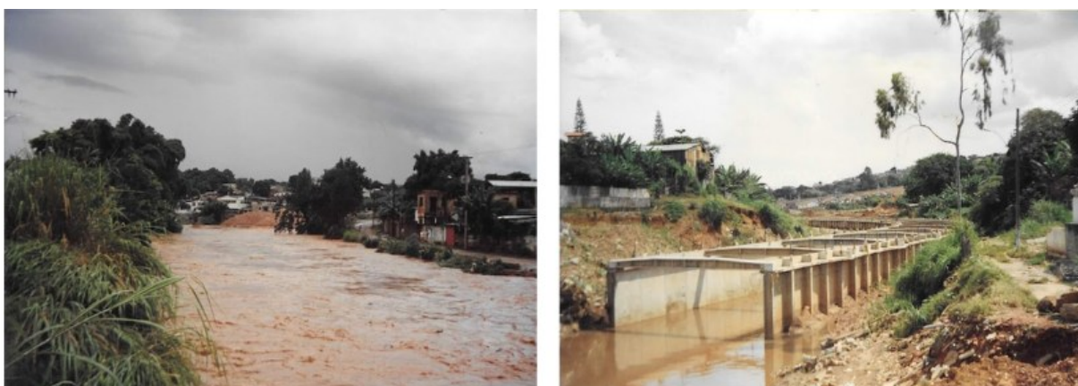
Figura 8 -:Obras de canalização do Ribeirão Arrudas na Avenida Tereza Cristina
