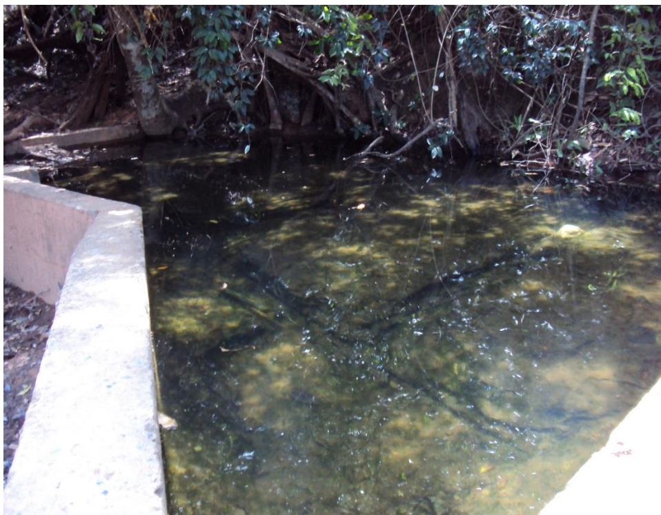
FOTO 11 – Poço da nascente na Aldeia Prata, protegido por muro de alvenaria (abril, 2012)
