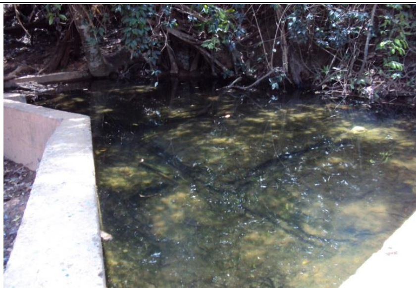
FOTO 11 – Poço da nascente na Aldeia Prata, protegido por muro de alvenaria (abril, 2012)
