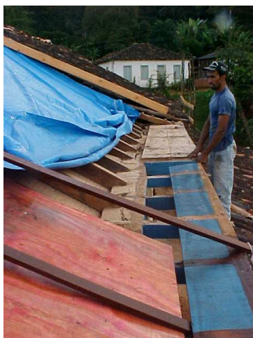
FIGURA 68: Início das obras da Igreja de Santo Antônio. Execução de andaime fachadeiro com peças de eucalipto e tábuas. Execução de calha de madeira para a retirada das telhas escorregando pela mesma. Opção pela retirada de todas as telhas que se encontravam bastante porosas e sem permeabilidade. Desmonte, por partes, do telhado da nave para que a edificação não ficasse exposta ao tempo. Uso de lona para cobertura provisória. Calha para descida das telhas. Detalhe da estrutura do telhado em caibro armado, frechal e cachorrada com guarda-pó de madeira. Execução de rampa para acesso de pessoas e materiais até o alto do andaime e da cobertura. Frechal da fachada lateral direita (lado do Evangelho) esfalfando. Fonte: fotos da autora, acervo do IEPHA/MG. Data: 18 maio 2004.
