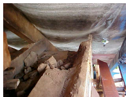
FIGURA 68: Início das obras da Igreja de Santo Antônio. Execução de andaime fachadeiro com peças de eucalipto e tábuas. Execução de calha de madeira para a retirada das telhas escorregando pela mesma. Opção pela retirada de todas as telhas que se encontravam bastante porosas e sem permeabilidade. Desmonte, por partes, do telhado da nave para que a edificação não ficasse exposta ao tempo. Uso de lona para cobertura provisória. Calha para descida das telhas. Detalhe da estrutura do telhado em caibro armado, frechal e cachorrada com guarda-pó de madeira. Execução de rampa para acesso de pessoas e materiais até o alto do andaime e da cobertura. Frechal da fachada lateral direita (lado do Evangelho) esfalfando. Fonte: fotos da autora, acervo do IEPHA/MG. Data: 18 maio 2004.
