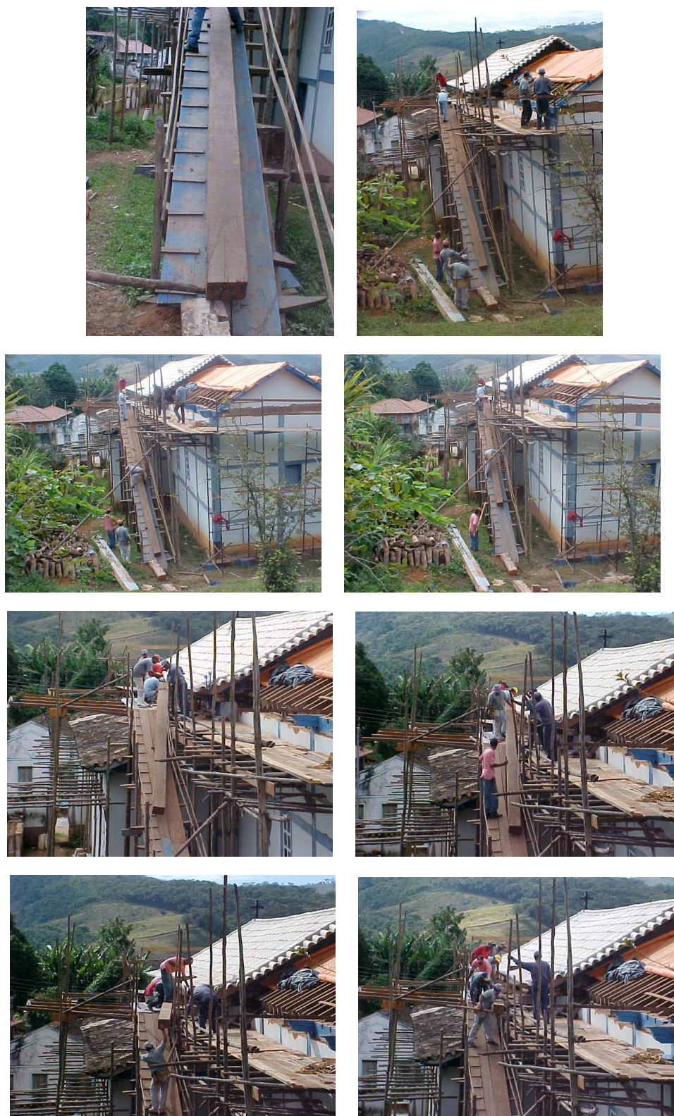
FIGURA 73: Obras da Igreja de Santo Antônio. Vistas de um frechal sendo içado para o andaime para ser colocado arrematando a parede da capela-mor. Foram utilizadas correntes amarradas a uma catraca e a ajuda dos operários para elevarem as grandes peças de madeira.
