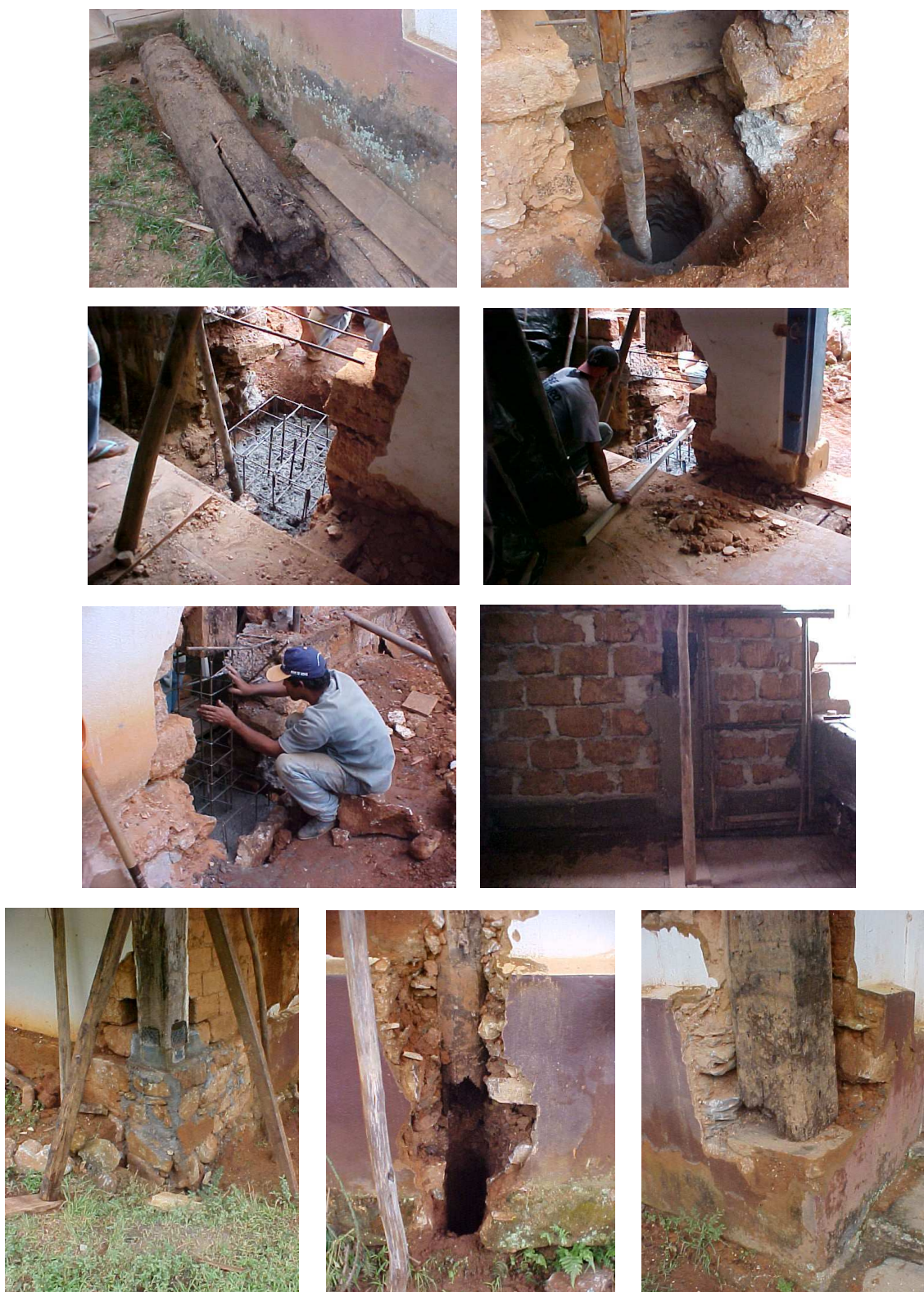
FIGURA 76: Obras da Igreja de Santo Antônio. Vista de nabo retirado de cava debaixo de esteio já cortado em intervenção anterior. Vista da cava com sapata de concreto no fundo. Esteio escorado com parte apodrecida cortada e substituída por sapata de concreto armado. Parede reconstruída com os adobes originais. Prospecção em todos os esteios pelo lado de fora, execução de escoramento e de cava para retirada do nabo deixado ali na última restauração, execução de uma sapata de concreto armado até a altura do esteio e emendado com placas de ferro. Fonte: fotos da autora, acervo do IEPHA/MG. Data: 20 outubro 2004.
