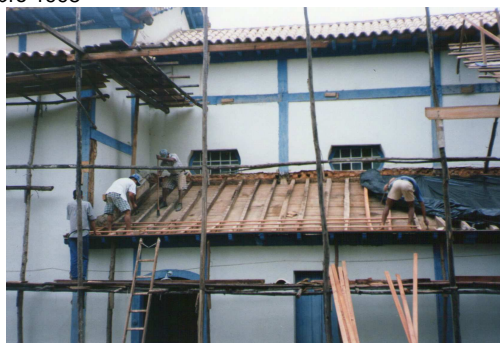
FIGURA 60: Obras do Santuário. Vistas das rampas de acesso aos andaimes e aos telhados da nave e da capela-mor já restaurados. Desmonte e montagem das esquadrias da capela-mor com substituição de peças deterioradas. Limpeza do forro e restauração do telhado do corredor lateral da capela-mor. Vista do telhado da capela-mor pronto. Placa de obras. Vista dos telhados da nave, da capela-mor e da tribuna prontos. Restauração do telhado do corredor lateral à capela-mor. Fonte: fotos da autora, acervo do IEPHA/MG.
