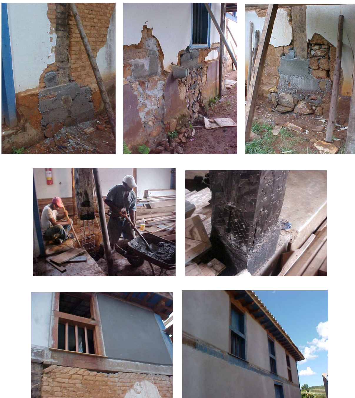
FIGURA 78: Remendo em todos os esteios com execução de sapata de concreto armado unido ao esteio com chapa de ferro. Restauração das esquadrias com substituição de peças de madeira deteriorada. Execução de janela rasgada com guarda-corpo. Execução de reboco sobre alvenaria de adobe.
