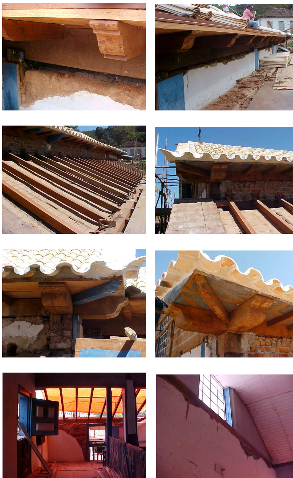
FIGURA 74: Obras da Igreja de Santo Antônio. Detalhe dos cachorros entalhados em peito de pomba. Construção do telhado da tribuna. Vista dos caibros das tribunas. Detalhe dos tirantes e cachorros esculpidos. Detalhe do cruzamento e arremate das cabeças de frechal com cachorro central e arremate da telha em ponta. Vista interna da reconstrução do telhado da tribuna. Reconstrução da alvenaria da empena do frontispício. Fonte: fotos da autora, acervo do IEPHA/MG. Data: 17 agosto e 02 setembro 2004.
