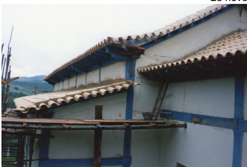
FIGURA 60: Obras do Santuário. Vistas das rampas de acesso aos andaimes e aos telhados da nave e da capela-mor já restaurados. Desmonte e montagem das esquadrias da capela-mor com substituição de peças deterioradas. Limpeza do forro e restauração do telhado do corredor lateral da capela-mor. Vista do telhado da capela-mor pronto. Placa de obras. Vista dos telhados da nave, da capela-mor e da tribuna prontos. Restauração do telhado do corredor lateral à capela-mor. Fonte: fotos da autora, acervo do IEPHA/MG.
