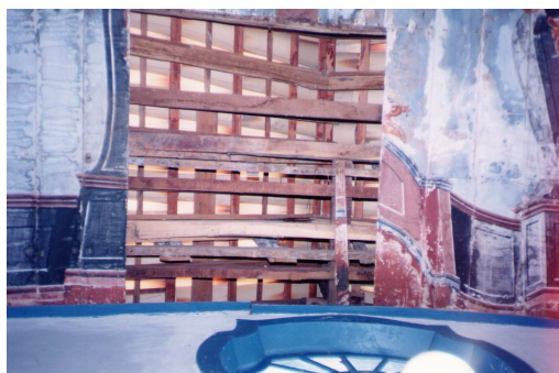
FIGURA 58: Obras do Santuário. Tábuas dos forros artísticos bastante deterioradas e retiradas para restauração da pintura com substituição do suporte de madeira. Vista do forro da nave. Vista geral do forro da nave e andaimes de ferro.
