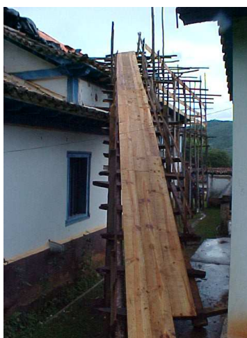
FIGURA 68: Início das obras da Igreja de Santo Antônio. Execução de andaime fachadeiro com peças de eucalipto e tábuas. Execução de calha de madeira para a retirada das telhas escorregando pela mesma. Opção pela retirada de todas as telhas que se encontravam bastante porosas e sem permeabilidade. Desmonte, por partes, do telhado da nave para que a edificação não ficasse exposta ao tempo. Uso de lona para cobertura provisória. Calha para descida das telhas. Detalhe da estrutura do telhado em caibro armado, frechal e cachorrada com guarda-pó de madeira. Execução de rampa para acesso de pessoas e materiais até o alto do andaime e da cobertura. Frechal da fachada lateral direita (lado do Evangelho) esfalfando. Fonte: fotos da autora, acervo do IEPHA/MG. Data: 18 maio 2004.
