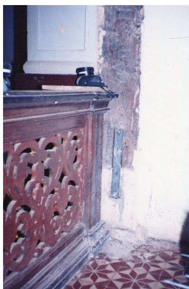
FIGURA 59: Obras do Santuário. Detalhe da ponteira do telhado. Vista do telhado da tribuna restaurado. Vista superior do camarim do retábulo-mor quando da restauração do telhado da capela-mor. Substituição de folhas de janelas com aproveitamento da ferragem original e instalação de sistema de alarmes. Restauração de esteio embutido na parede com emenda feita com chapa de ferro. Restauração de esquadria. Fonte: fotos da autora, acervo do IEPHA/MG.
