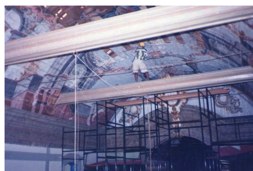
FIGURA 58: Obras do Santuário. Tábuas dos forros artísticos bastante deterioradas e retiradas para restauração da pintura com substituição do suporte de madeira. Vista do forro da nave. Vista geral do forro da nave e andaimes de ferro.
