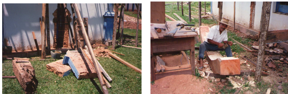
FIGURA 61: Obras do Santuário. Restauração do forro artístico da capela-mor com descida de tábuas apodrecidas para troca do suporte, higienização, imunização e fixação da pintura. Vista dos telhados da capela-mor e do corredor lateral esquerdo prontos. Início da restauração do telhado do corredor lateral direito. Substituição de frechal com escoramento do telhado. Restauração do soco dos esteios do frontispício. Sr. Amantino esculpindo verga para a porta principal. Fonte: fotos da autora, acervo do IEPHA/MG.
