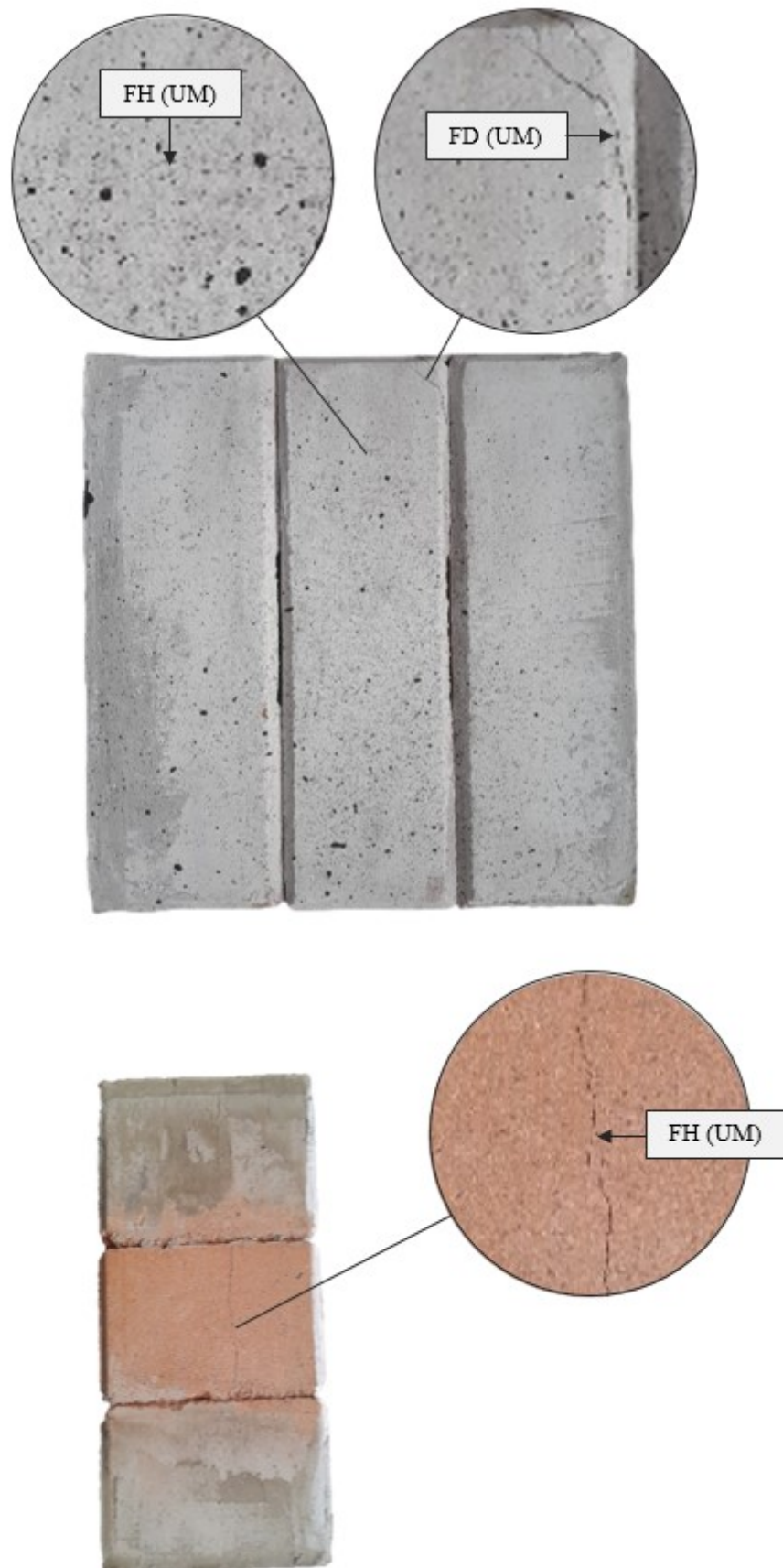
Figura C.23 – Registro detalhado do modo de falha do prisma P_{CA2} ( \sigma_c = 0,1 MPa), evidenciando fissuras: horizontais, FH(UM); diagonal, FD(UM); sem separação das unidades.
