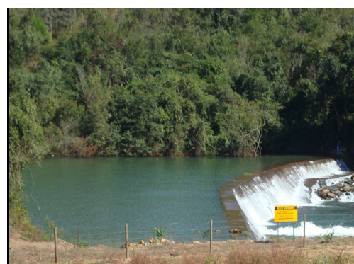
Figura 7: Soleiras vertentes concluídas (2008) no trecho a jusante da UHE Amador Aguiar I, rio Araguari – MG. Fotos: Simone Mendes (2008)
