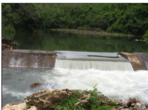
Figura 7: Soleiras vertentes concluídas (2008) no trecho a jusante da UHE Amador Aguiar I, rio Araguari – MG. Fotos: Simone Mendes (2008)
