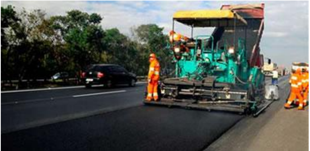
Figura 3.2: Aplicação do asfalto-borracha na rodovia dos Bandeirantes no trecho entre São Paulo e Campinas em 2011
