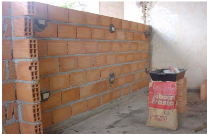
FIGURA 17 - Colocação dos pontos para espessura do revestimento argamassado (sem chapisco).
