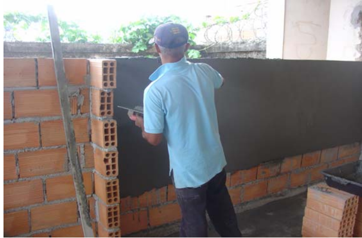
FIGURA 19 - Regularização da argamassa após o sarrafeamento da argamassa.
