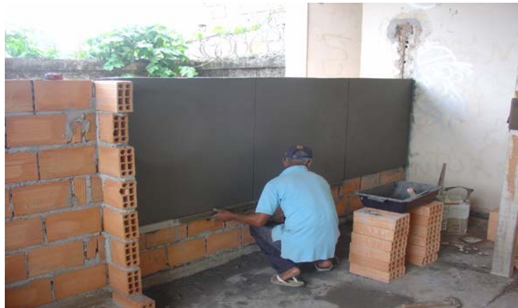
FIGURA 20 - Painel de revestimento sarrafeado e desempenado liso.
