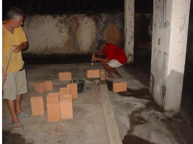
FIGURA 13 - Início da execução da alvenaria para revestimento argamassado sobre base cerâmica (sem chapisco).
