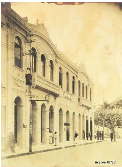
Figura 6: Fotografia do Prédio onde funcionou a Faculdade de Direito de Santa Catarina, 1932 Acervo Fotográfica da Universidade Federal de Santa Catarina
