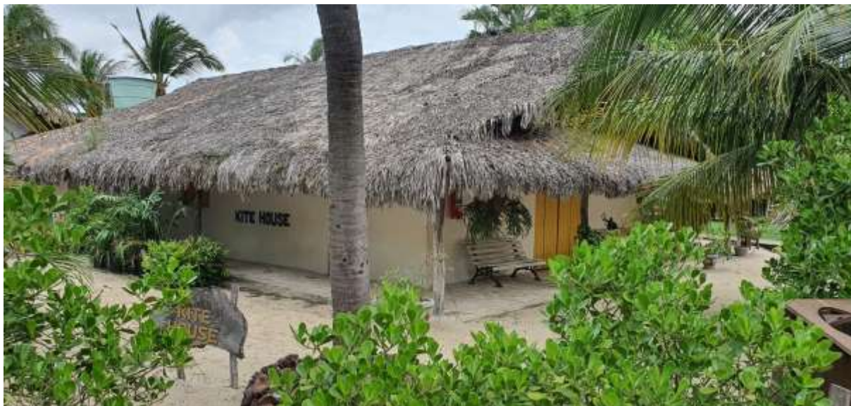
Figura 21 – Kite House , em Barra Grande, município de Cajueiro da Praia
