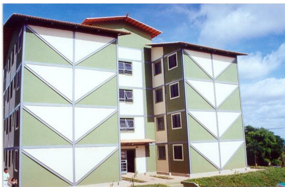
FIGURA 3.1 – Fachada de um edifício residencial de baixo custo de quatro pavimentos.
