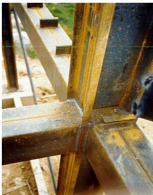
FIGURA 3.4 – Detalhe das ligações entre vigas e pilares.
