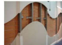
Infraestrutura em Drywall
