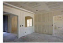
Paredes em Drywall
