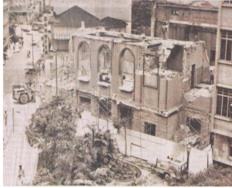
Figura 3: Demolição do Cinema Metr pole para construção de uma agência bancária, 1983.
