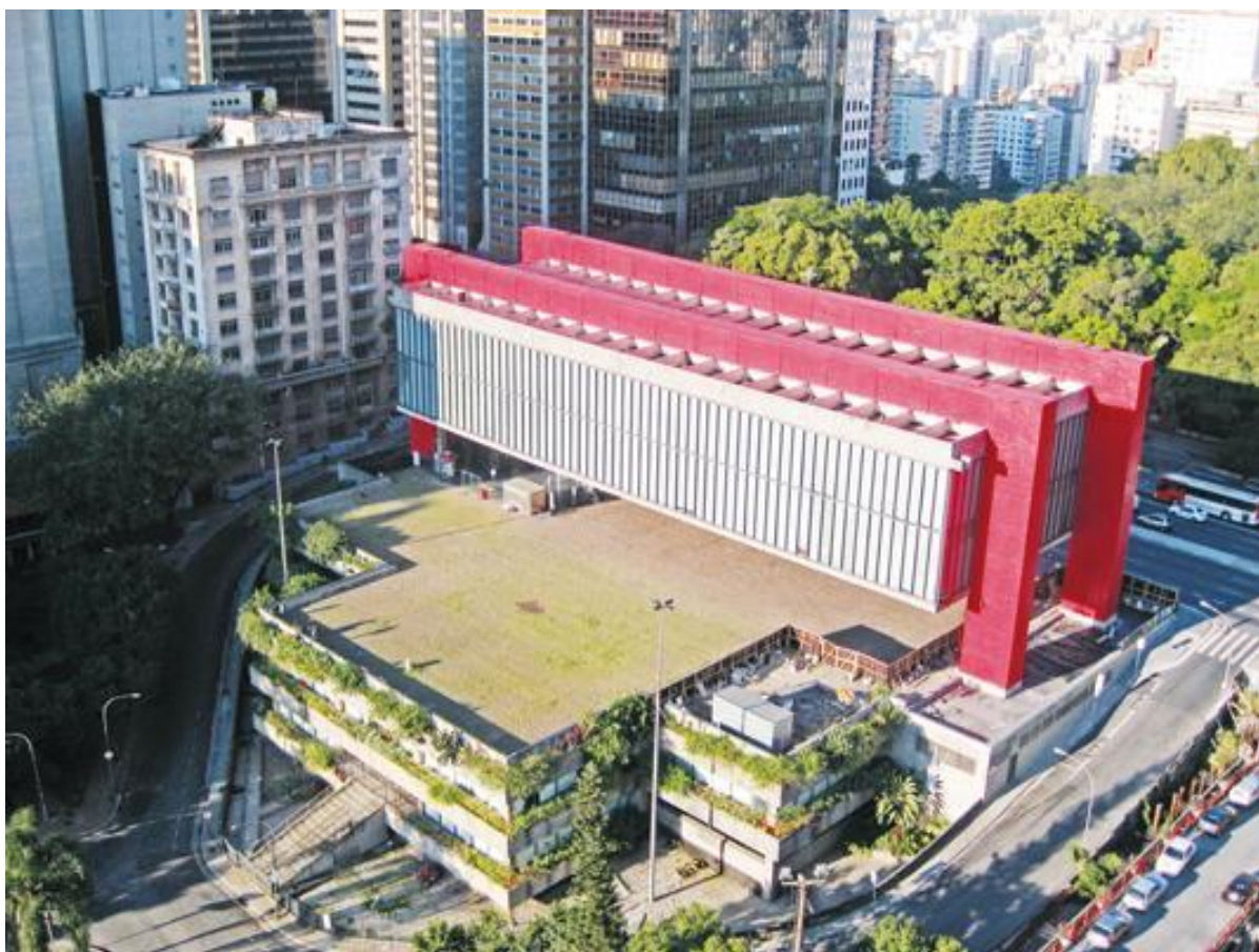
Figura 2. 12– MASP- Vista do conjunto de edificações do MASP
