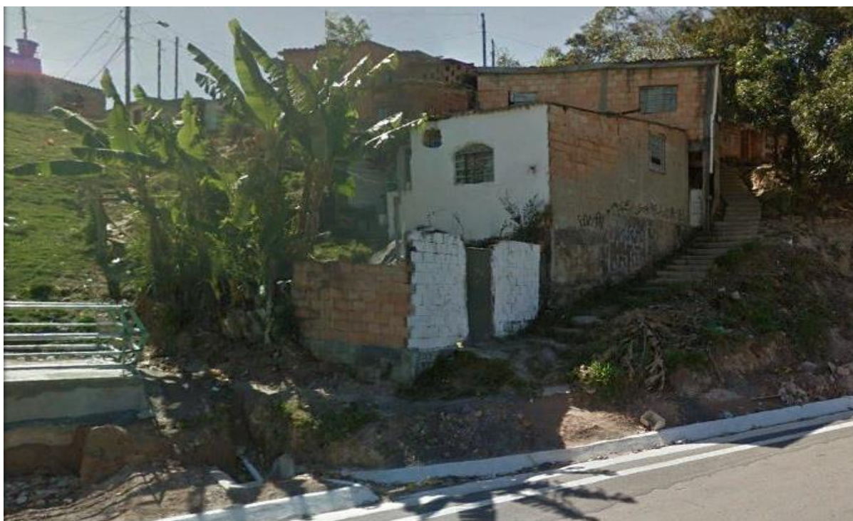
Figura 3. 22 – Edificação em Ocupação Irregular na faixa de domínio da rodovia MG 424
