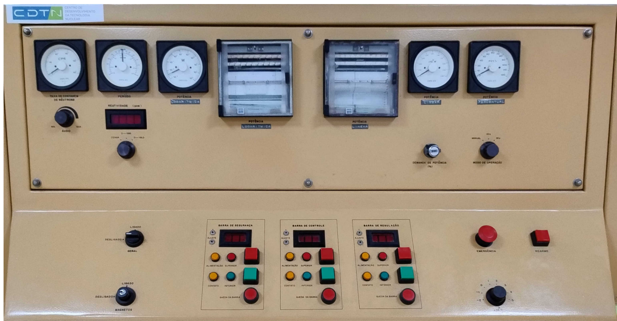
Figura 3 - Indicadores do SMAR e SMRA na mesa de controle, e central de alarmes.
