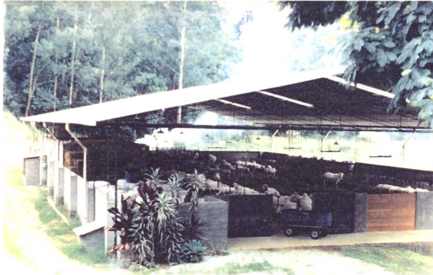
Figura 7. Vista geral de um cabril de estrutura metálica e alvenaria, com piso de cama, de uma das propriedades classificadas como nível 2 na região serrana do Estado do Rio de Janeiro (2002).
