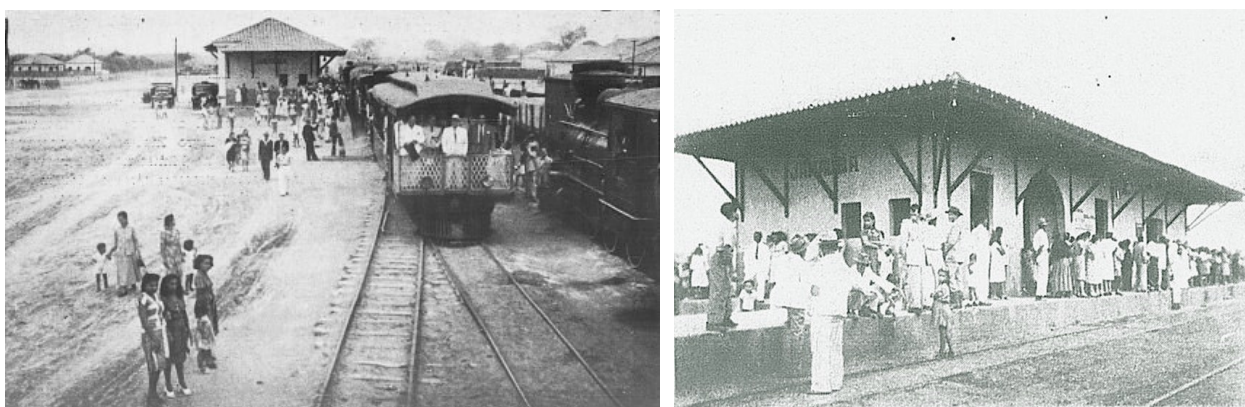
Figura 41 Estação de Trem de Janaúba
