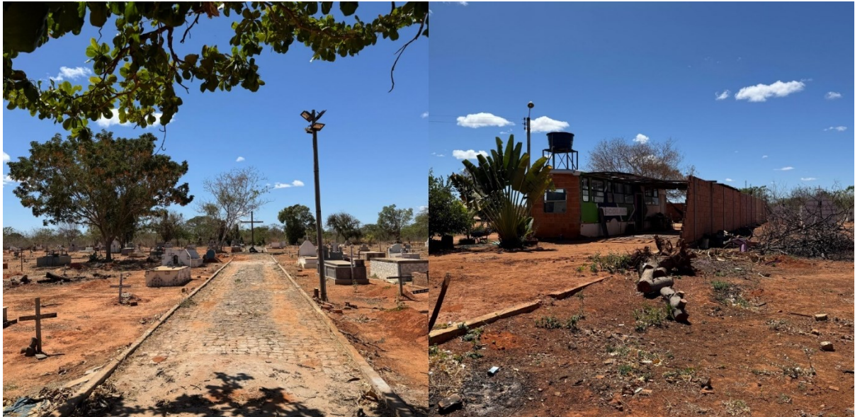
Figura 55 Interior do Cemitério 'Novo'
