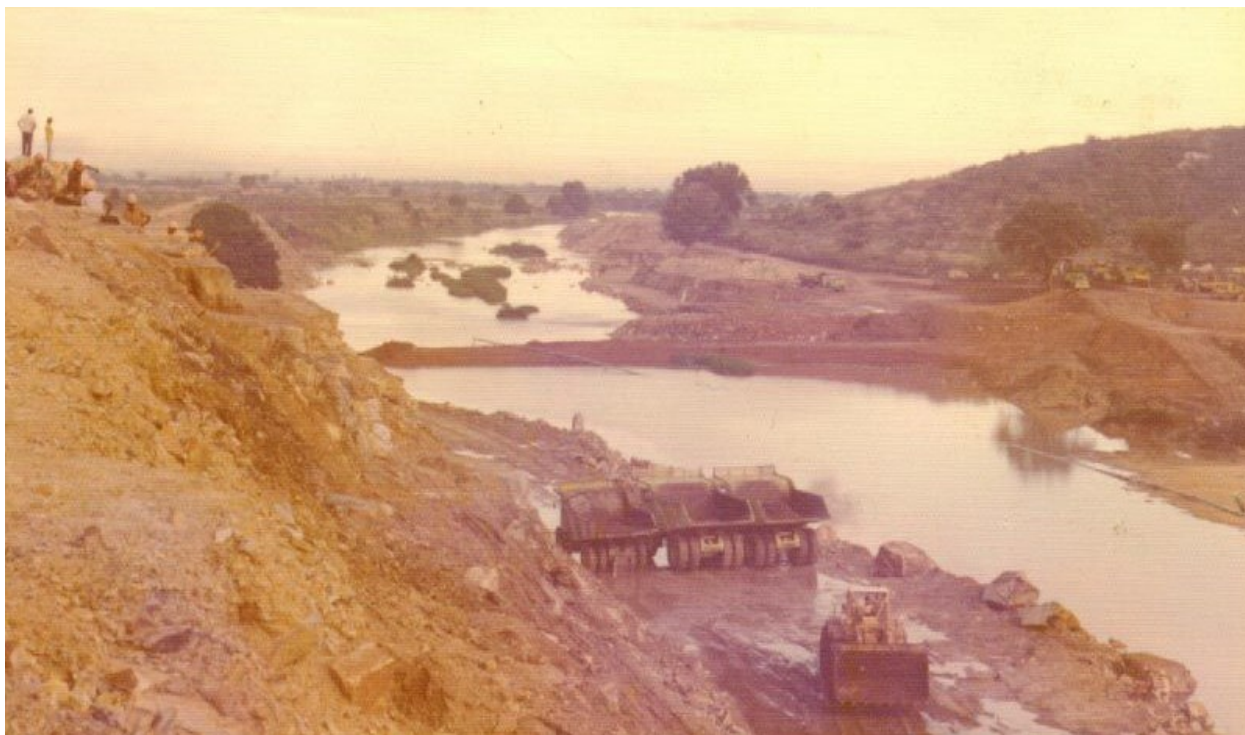
Figura 42 Construção da Barragem – 1978
