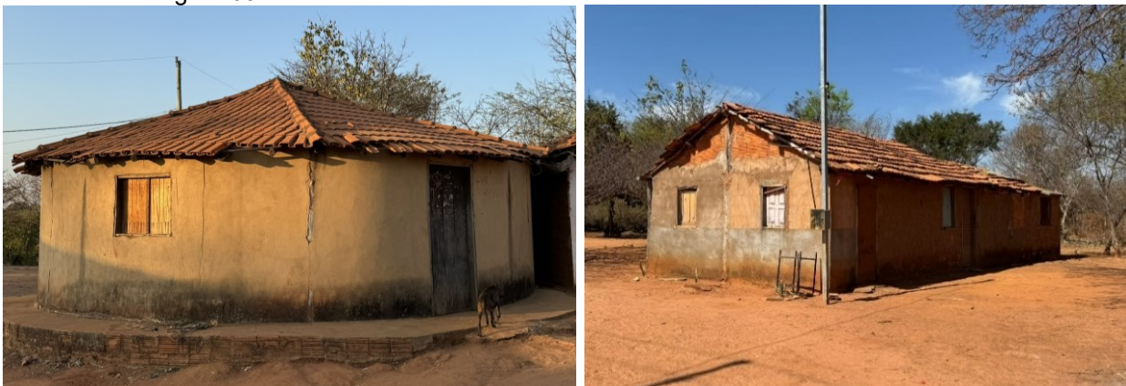
Figura 63 Redondo e uma residência no Assentamento Rio São Francisco
