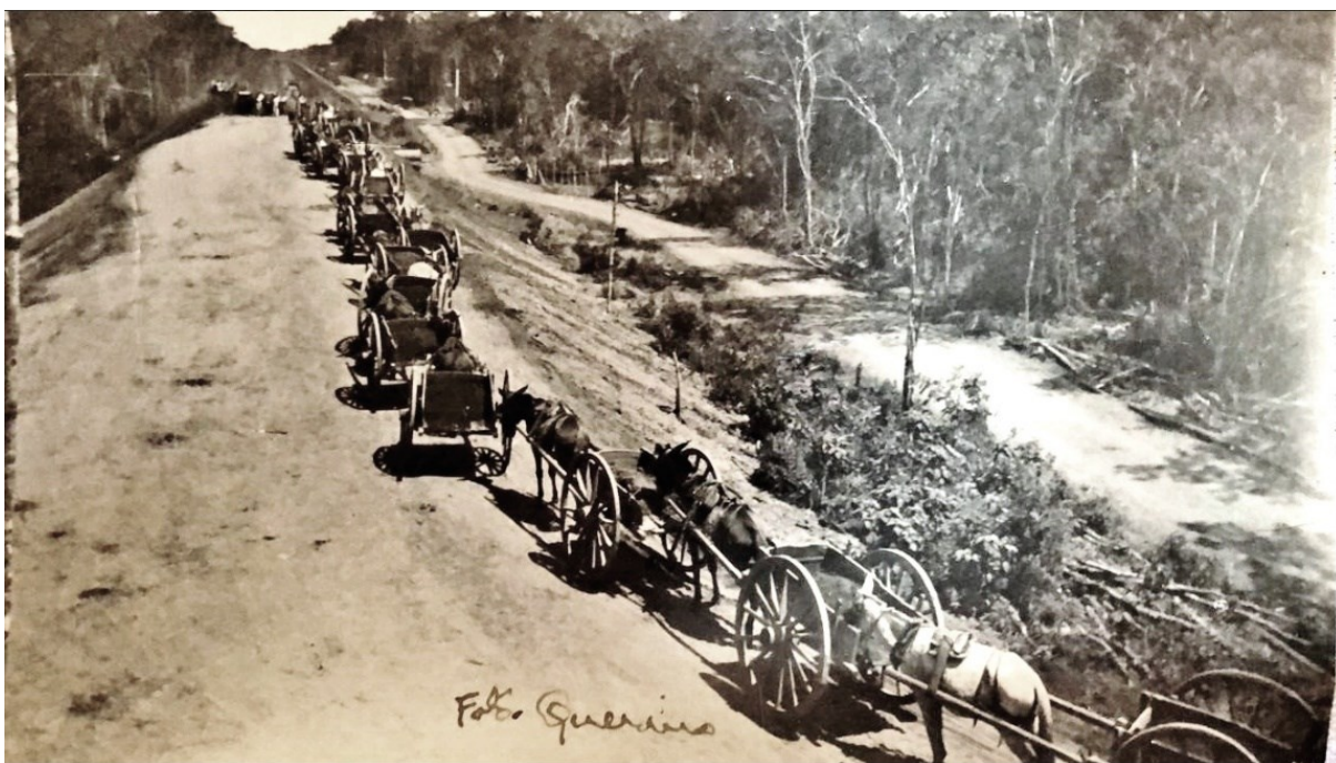
Figura 37 Escavação e carroças no trabalho de construção da rede ferroviária, 1940
