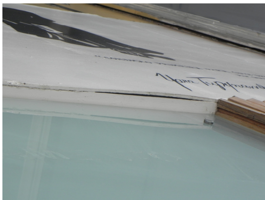
Figura 7: Abaulamentos Fonte: Arquivo do projeto (2019)
