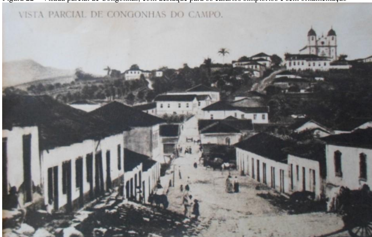
Figura 22 – Visada parcial de Congonhas, com destaque para os casarios simplórios e sem ornamentação
