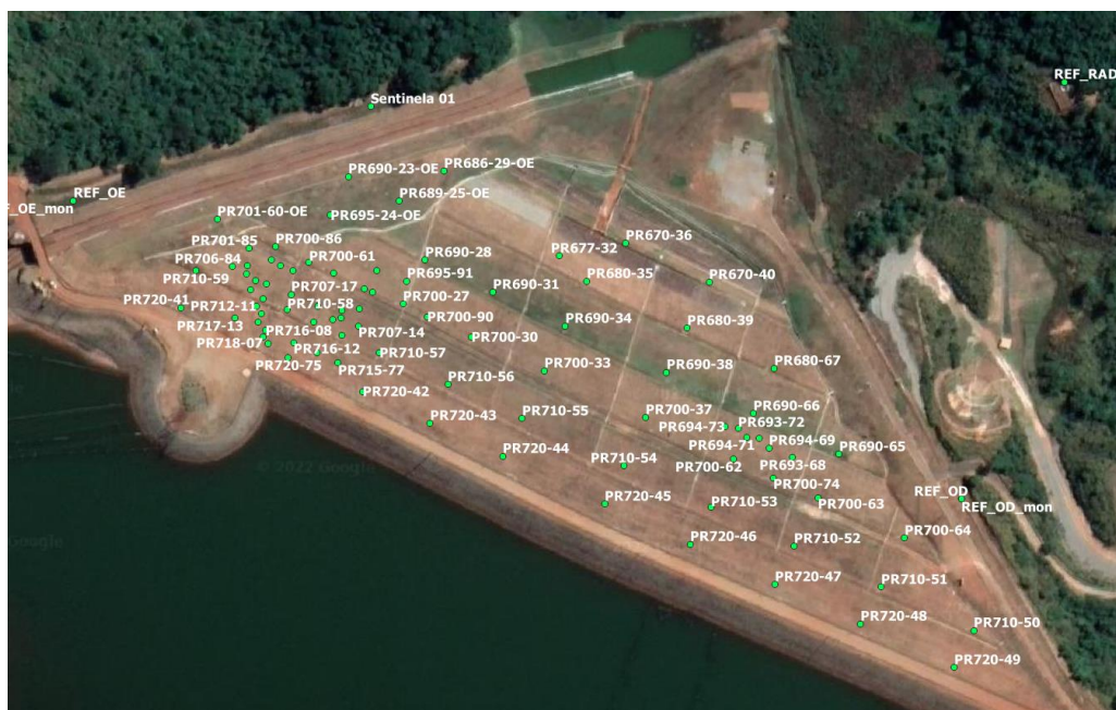
Figura 4: Vista aérea de prismas de monitoramento e de referência posicionados numa barragem. Fonte: Elaborado pelo autor.
