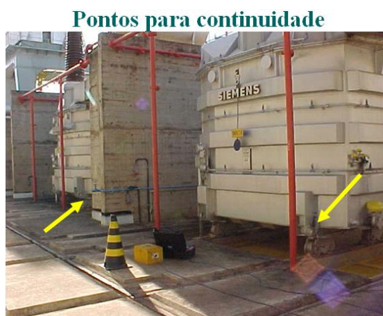
Figura 4.4 – Exemplo de pontos para medição de continuidade [adaptada da Apresentação CEMIG, Março 2008]
