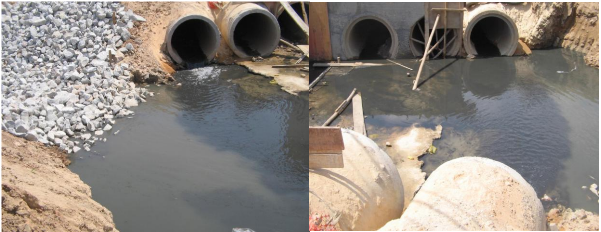
Figura 7.4: Conflência do córrego da rua Prentice Coelho com córrego Engenho Nogueira - Ponto 3
