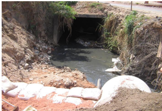
Figura 7.5: Córrego Engenho Nogueira a montante da confluência com o córrego da rua Prentice Coelho - Ponto 4.
