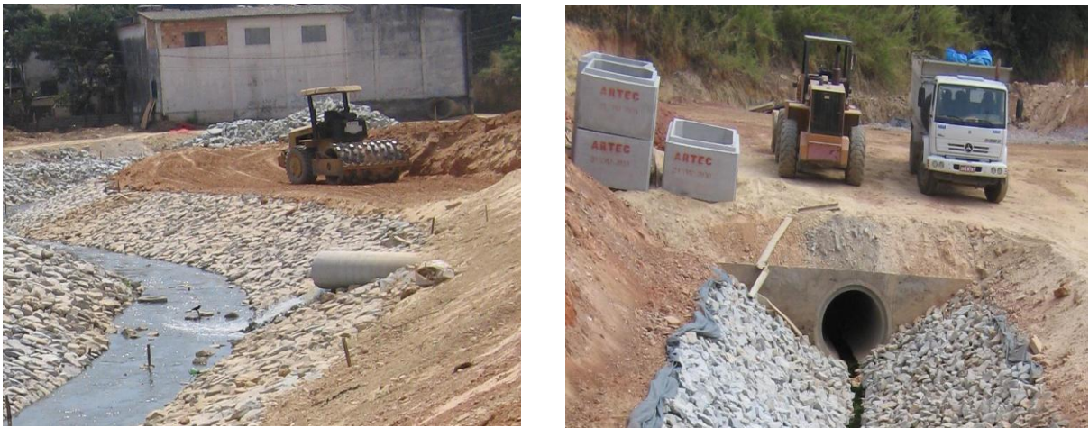
Figura 9.1: Obras no córrego Engenho Nogueira e Prentice Coelho.
