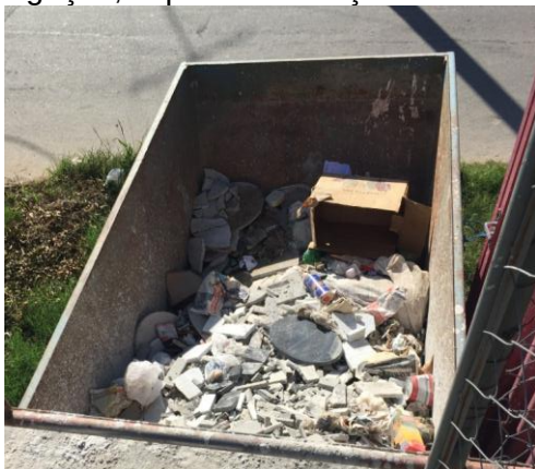
Figura 19 – Restos de apara de pedras armazenados em caçambas em vias públicas (fora da área do empreendimento), sem segregação, impermeabilização ou cobertura.
