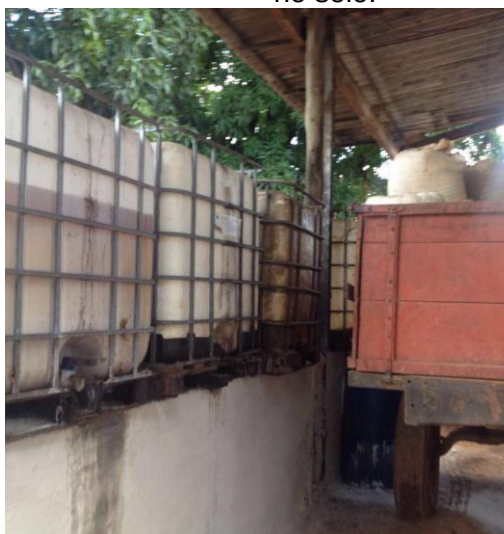
Figura 22 – Óleo usado armazenado em local aberto, sem bacia de contenção com vazamento no solo.
