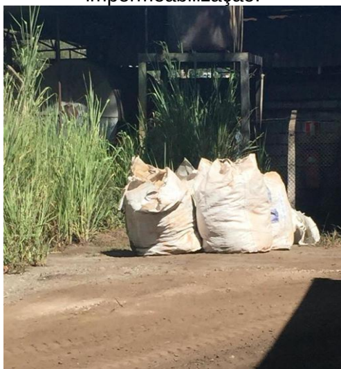
Figura 21 – Big-bags com resíduos perigosos diversos no solo, sem qualquer tipo de impermeabilização.
