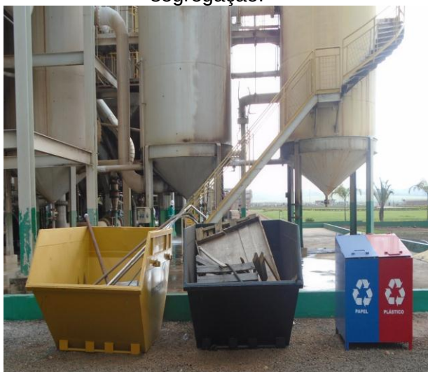
Figura 32 – Armazenagem de resíduos diversos no solo sem controle, com segregação.
