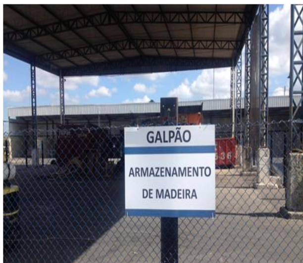
Figura 39 - Galpão identificado e com correto controle ambiental para o armazenamento de madeira reciclada
