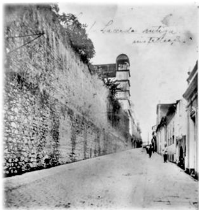
Figuras 65 e 66 – Elevador Lacerda em 1873 (antigo elevador da Conceição)
