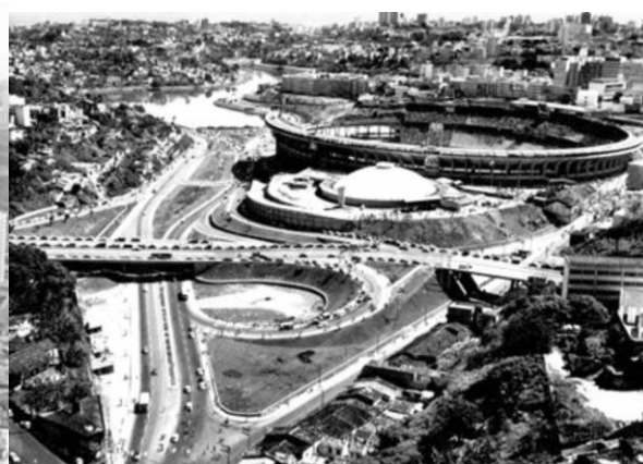
Figura 5 – Viaduto da Fonte Nova – 1971
