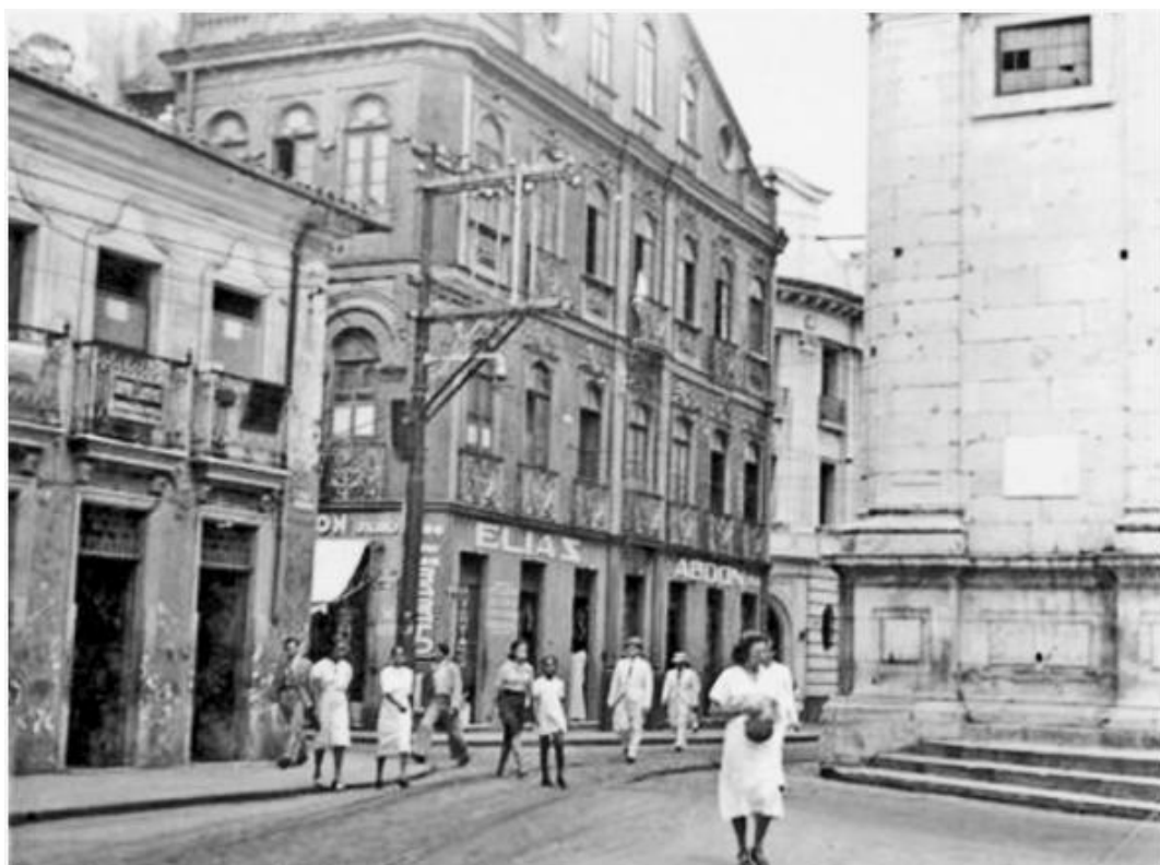
Figura 60 – Rua do Plano Inclinado Gonçalves
