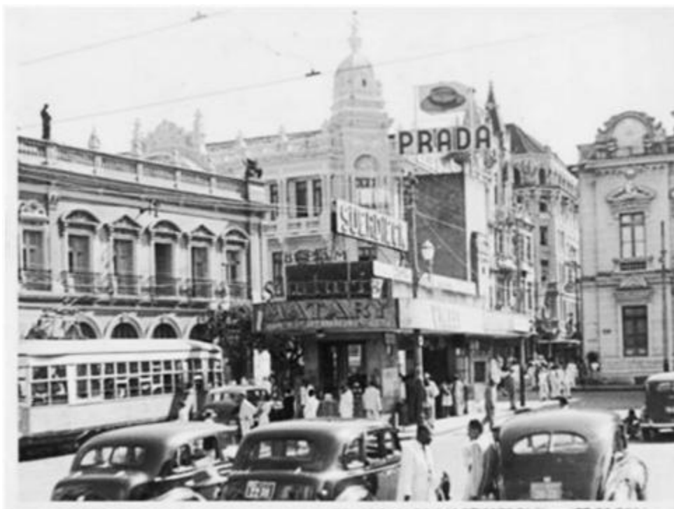
Figura 42 – Praça Municipal: acesso à Rua Chile Fonte: Anônimo
