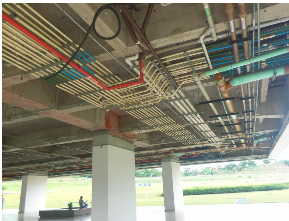
Foto 5 – Área Interna CAMG (2017)
