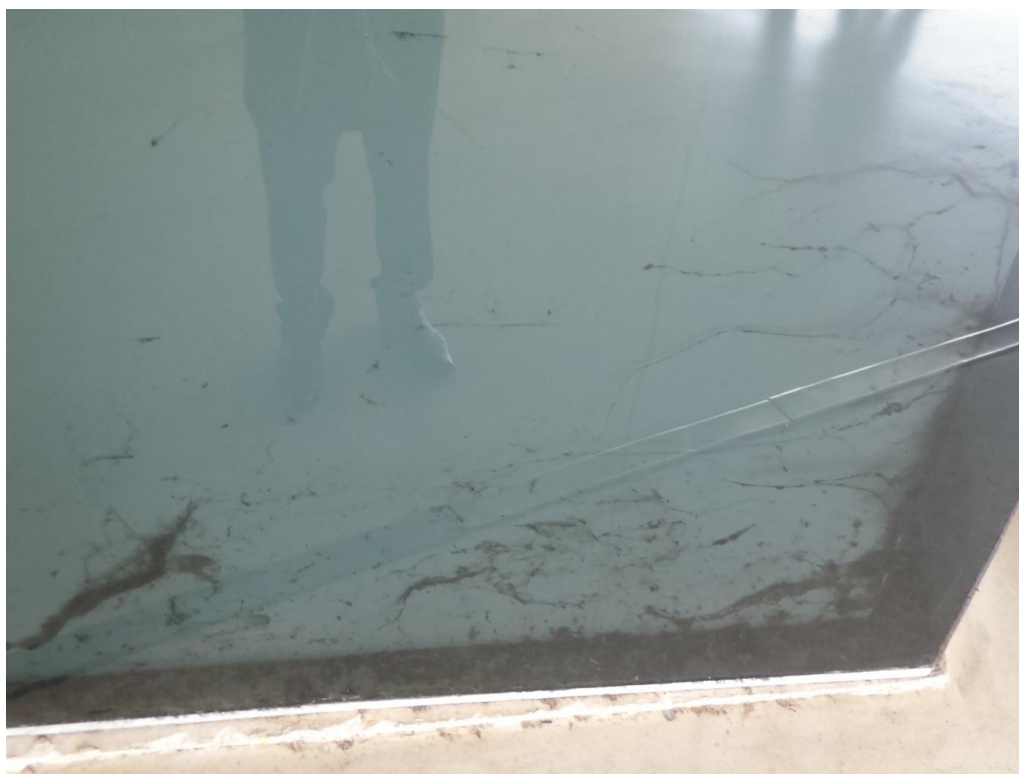
Foto 6 – Área Interna CAMG (2017)
