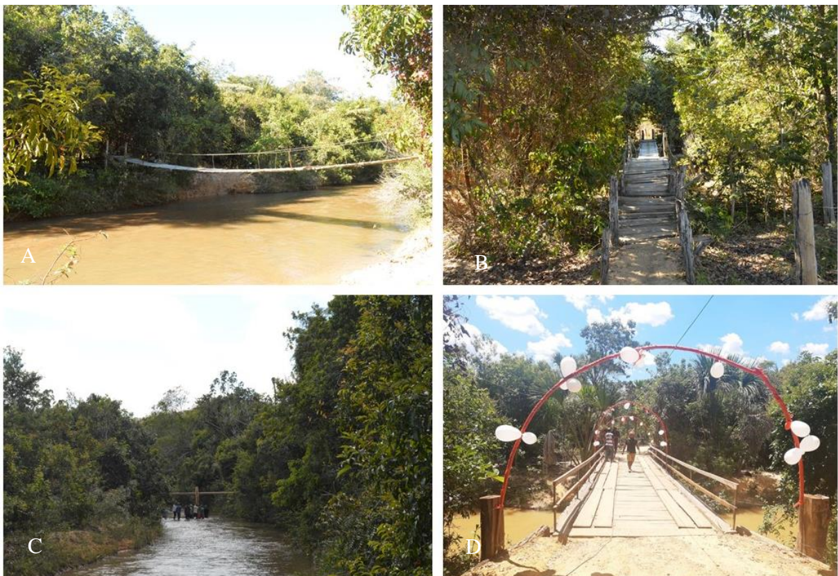
Figura 16 – Registros da ponte do Resfriado. (A) e (B): ponte antiga; (C): moradores dentro do rio Pandeiros durante a construção da nova ponte; (D): inauguração da nova ponte.
