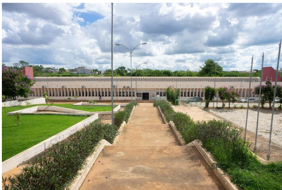
IFNMG - Campus Montes Claros (Prédio de Ensino I). Arquivo IFNMG, 2021.
