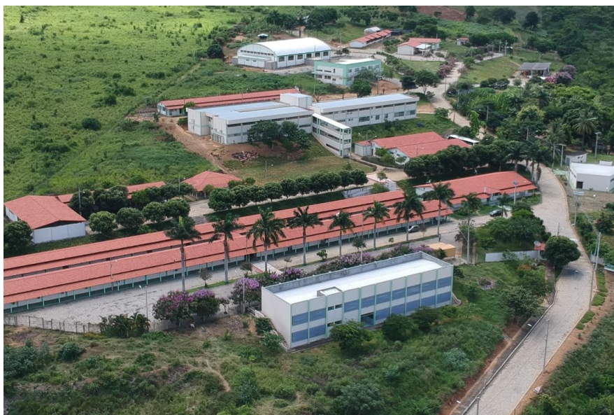
IFNMG - Campus Almenara (vista aérea). Foto Professor Alfredo Costa, 2021.
