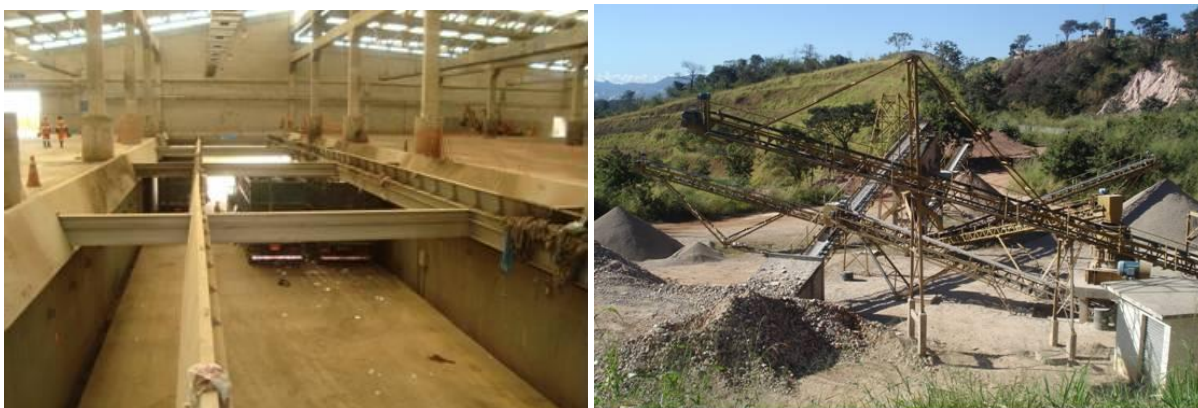
Figura 5.6: Estação de Transbordo de resíduos sólidos e Estação de Reciclagem de resíduos de construção e demolição do município de Belo Horizonte
