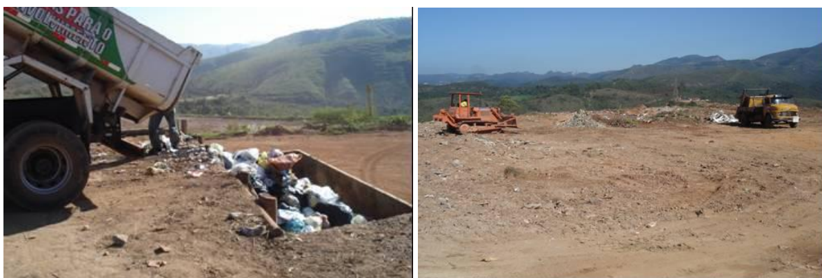
Figura 5.22: Estação de Transbordo e Aterro de inertes do município de Nova Lima
