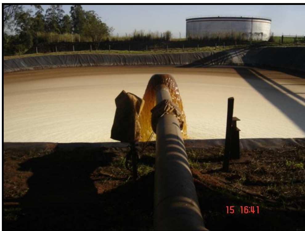
Figura 14. Foto Reservatório de armazenamento de vinhaça.
