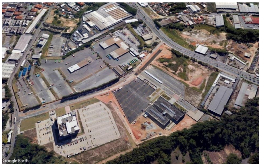
Figura 24 - Construção do Centro Universitário UNA na Sede. Ano de 2021
