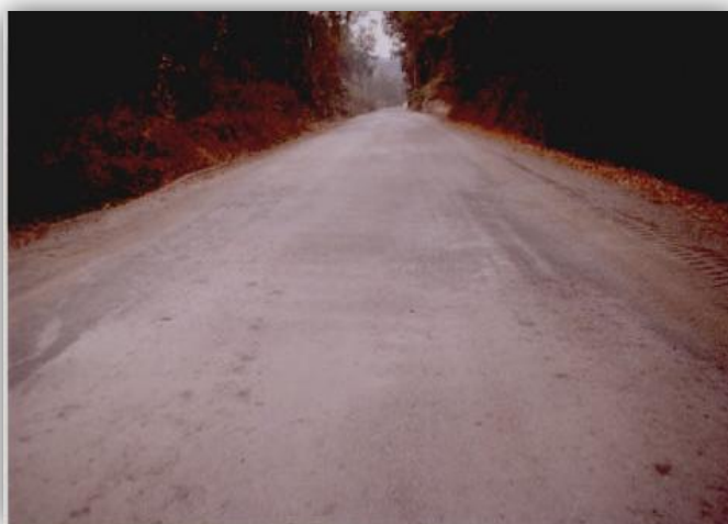
Figura 44 - Estrada imperial que liga Ouro Branco a Ouro Preto em Minas Gerais Escória utilizada da Açominas
