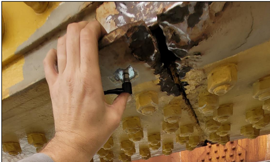
Figura 7 – Medição de espessura por ultrassom. (Fonte: Relatório interno de empresa de engenharia, 2024)
