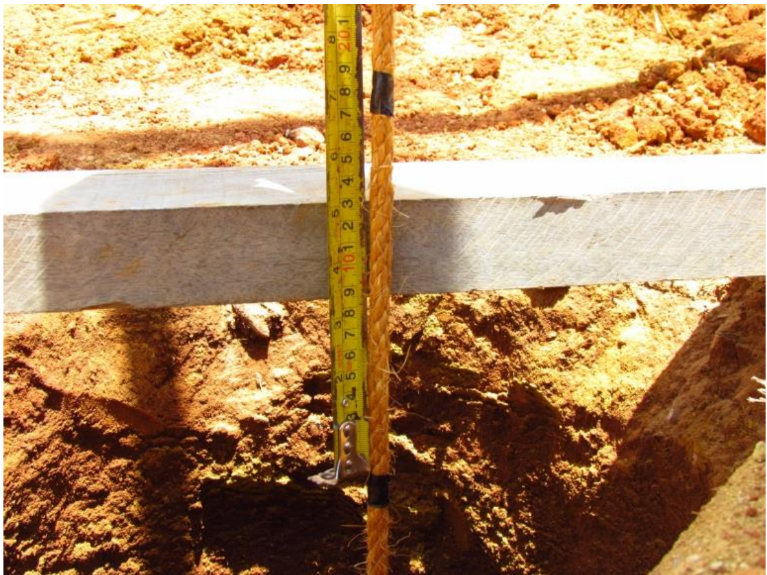
Figura 3.10: Medição da nega
