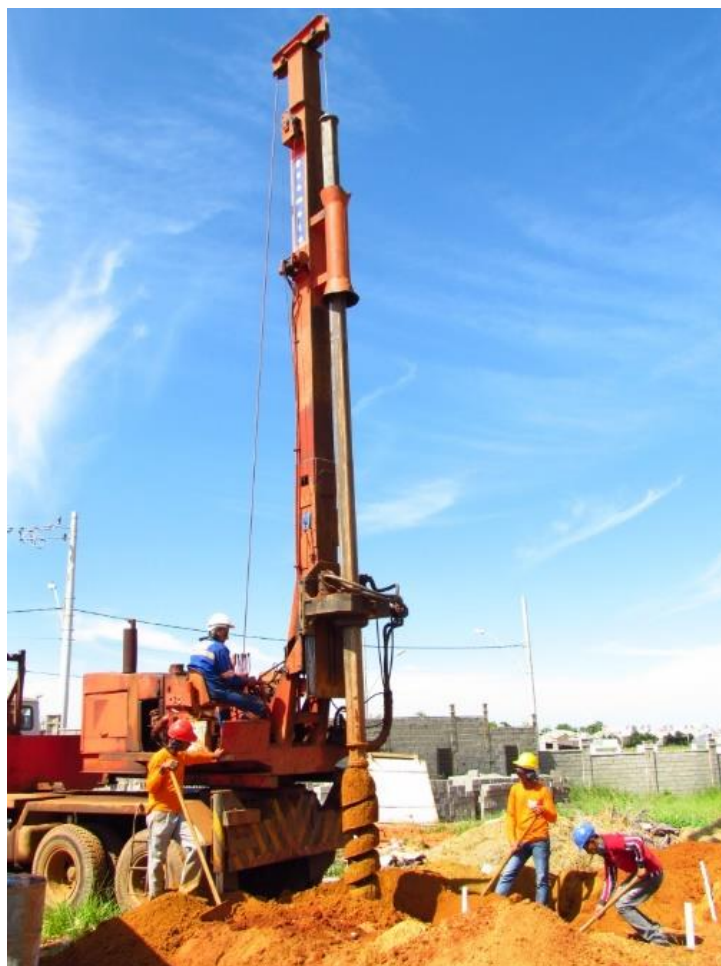
Figura 3.2: Equipamento trado mecanizado montado sobre caminhão
