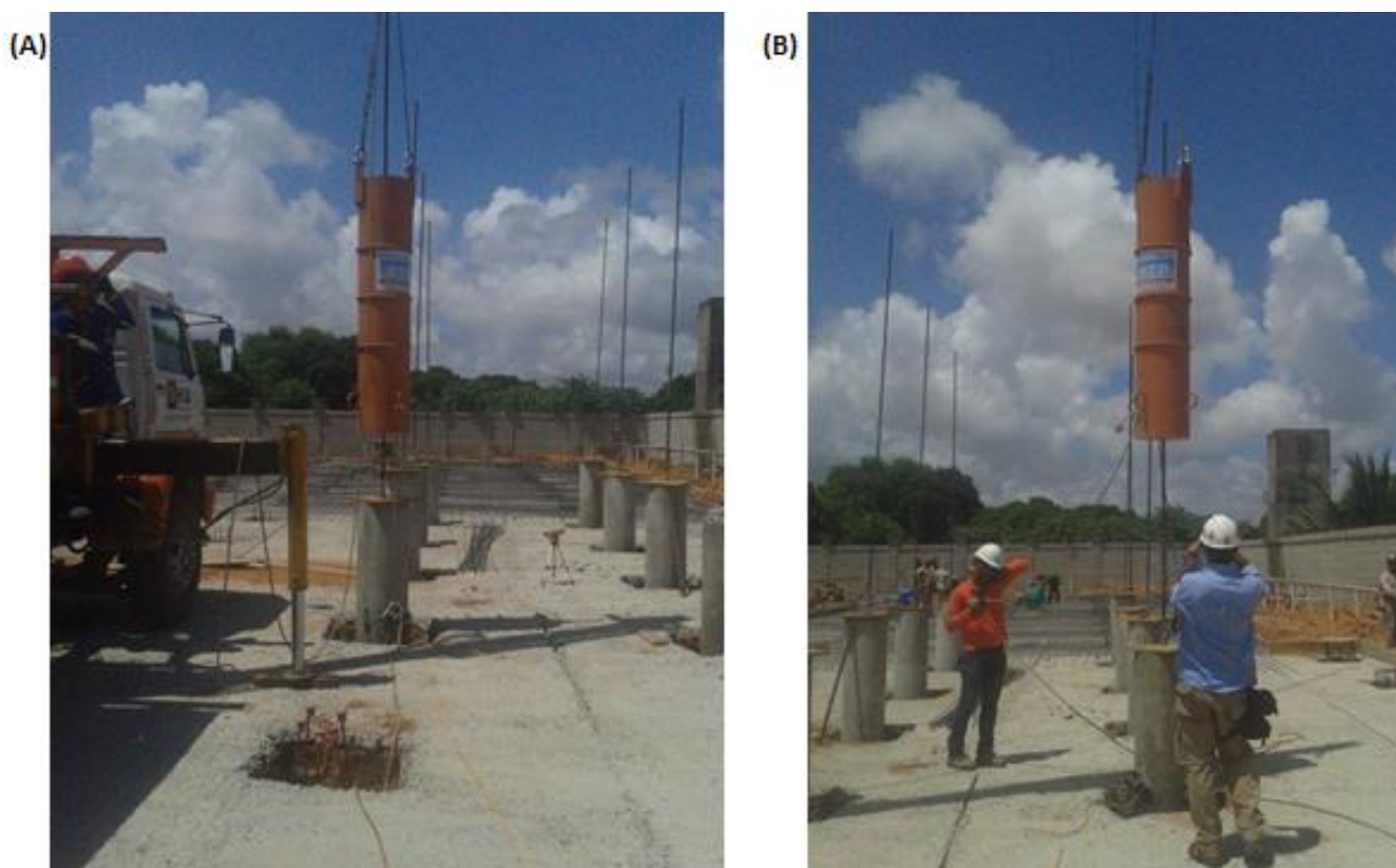
Figura 3.6: Acoplagem do martelo sobre o complemento das estacas para ensaio
