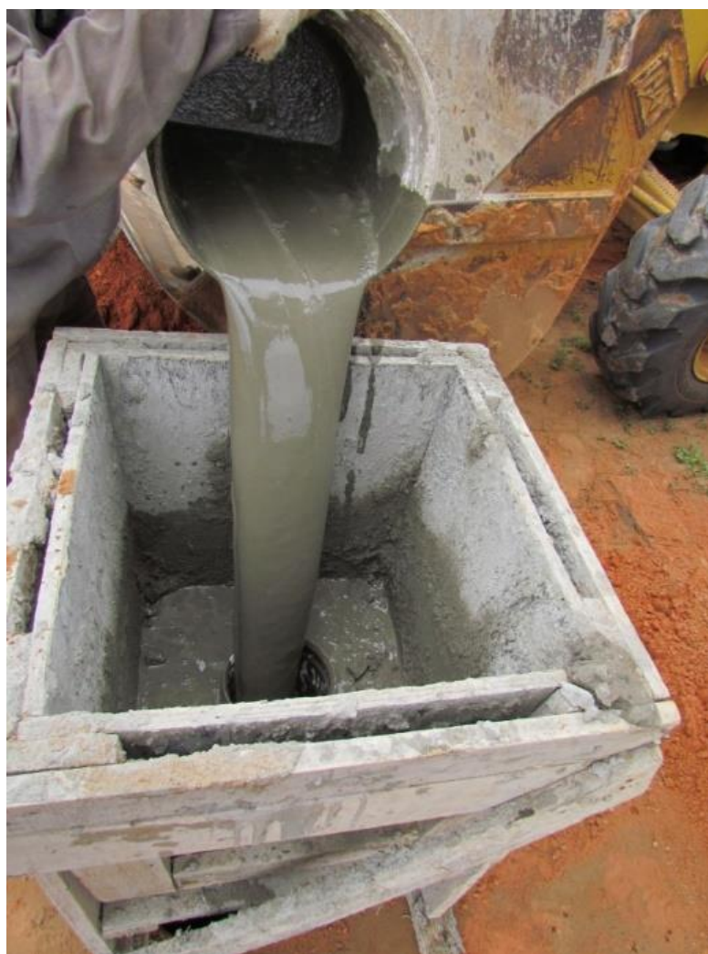
Figura 3.11: Lançamento da argamassa com auxílio do funil
