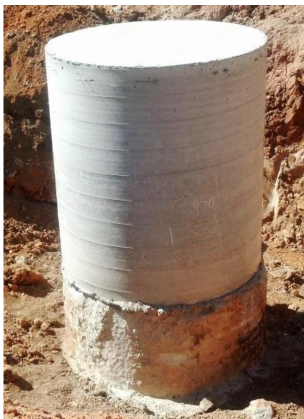
Figura 2.14: Complemento da cabeça da estaca
