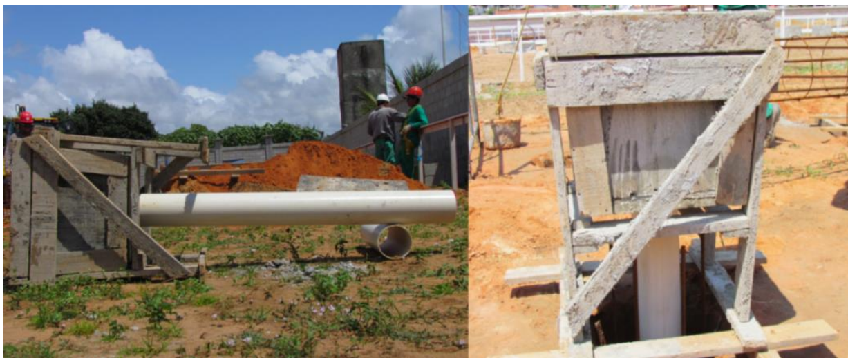
Figura 3.4: Funil utilizado para lançamento dos materiais.
