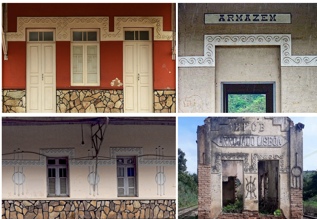
Figuras 24, 25, 26 e 27 – Ornamentos arquitetônicos compartilhados entre as estações ferroviárias do ramal Paraopeba Sul.
