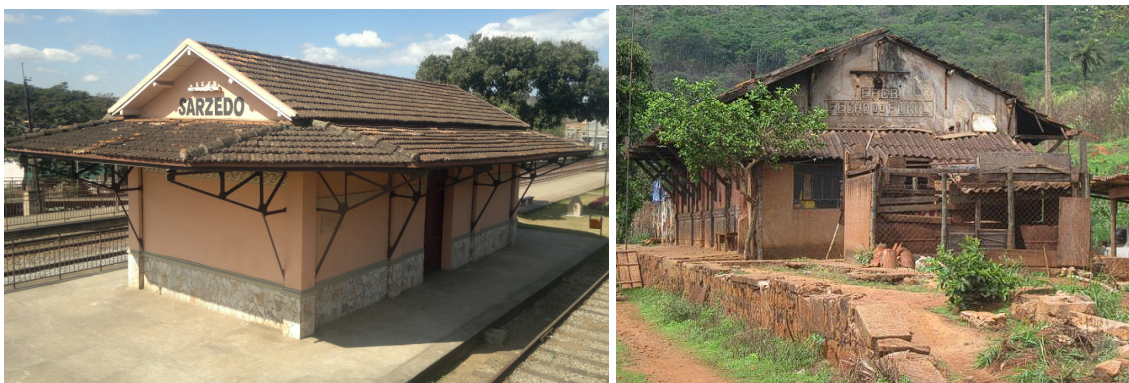
Figuras 34 e 35 – Estações ferroviárias do ramal Paraopeba Norte.
