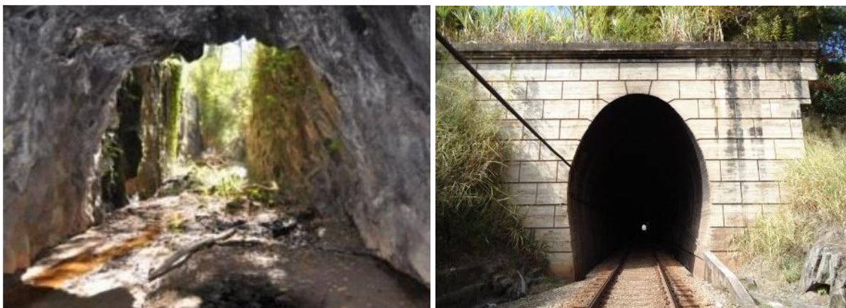
Figuras 60 e 61 – Túnel da Fortaleza (abandonado) e túnel em uso. Ambos localizados no município de Moeda–MG.
