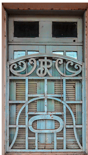
Figura 28 – Detalhe da esquadria da antiga bilheteria na estação ferroviária de Jeceaba, situada no Ramal Paraopeba Sul.
