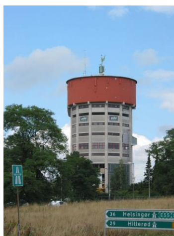
Figura 08: Caixa de água Fonte: Site Coletivo verde (2012)
