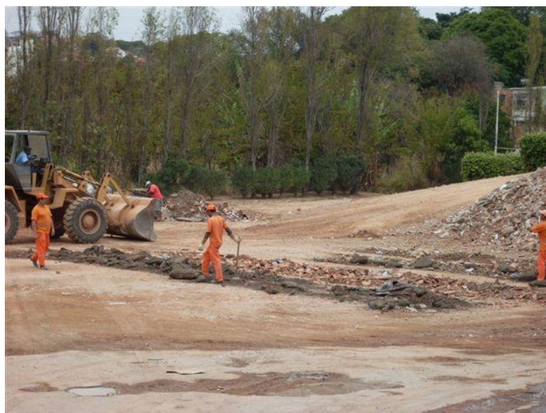
Figura 18: Segregação nas pilhas de material. Fonte: Pesquisa Direta, 2012.
