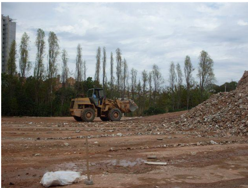
Figura 19: Máquina transportando o material para o britador. Fonte: Pesquisa Direta, 2012.
