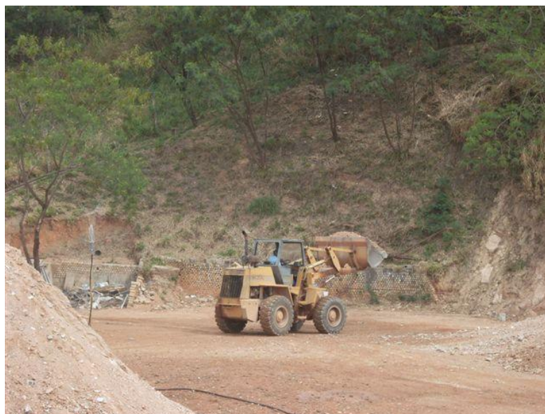
Figura 22: Máquina transportando o agregado reciclado para pilha central. Fonte: Pesquisa Direta, 2012.
