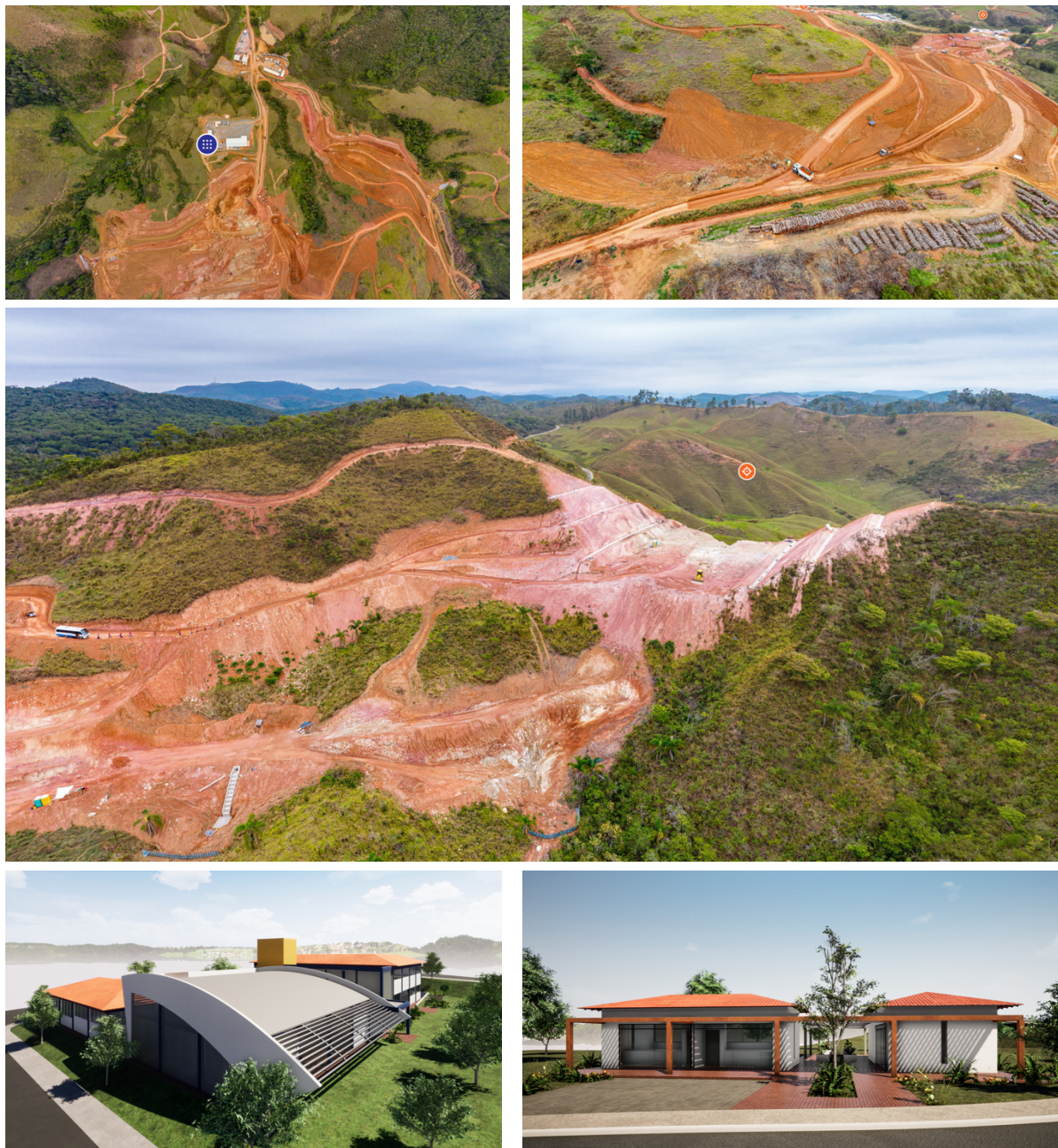
Figura 35: Imagens recentes das obras de reassentamento coletivo de Paracatu de Baixo e simulações dos equipamentos comunitários
