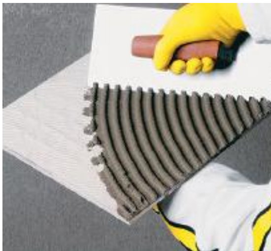
Figura 12: Preenchimento prévio das reentrâncias do tardo das placas cerâmicas com argamassa colante Fonte: WEBER, Saint-Gobain.
