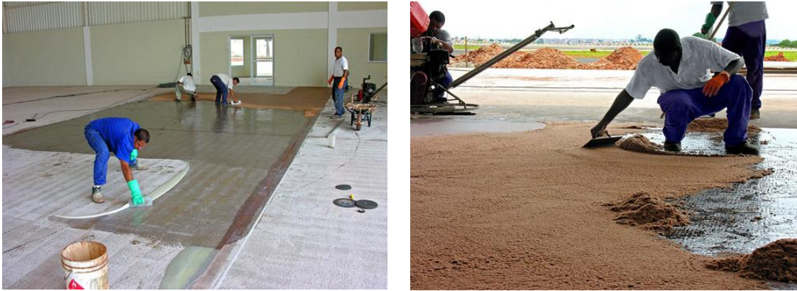
Figura 16: Execução do revestimento epóxi espatulado
