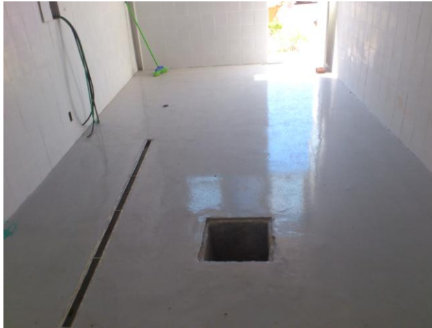
Figura 27: Revestimento de Alto Desempenho executado em Agosto/2012. Fonte: Acervo pessoal.
