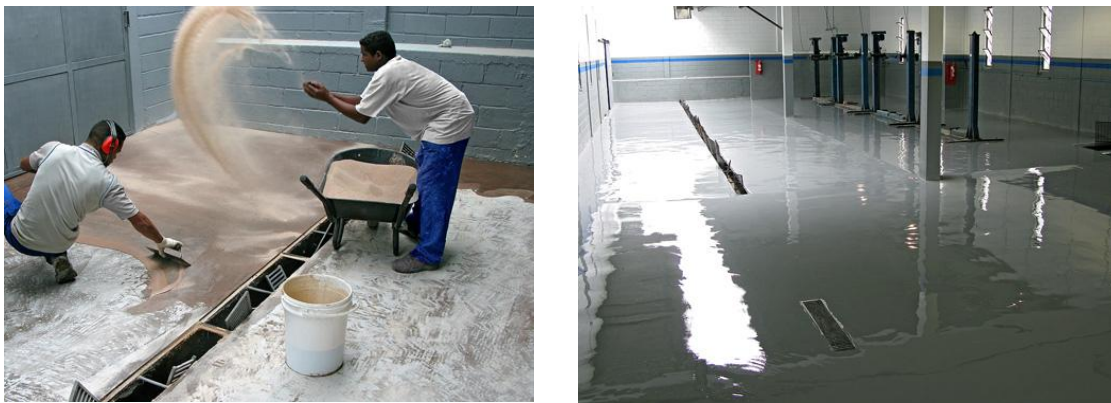
Figura 18: Aplicação do revestimento epóxi multicamadas Fonte: PINI PISOS.
