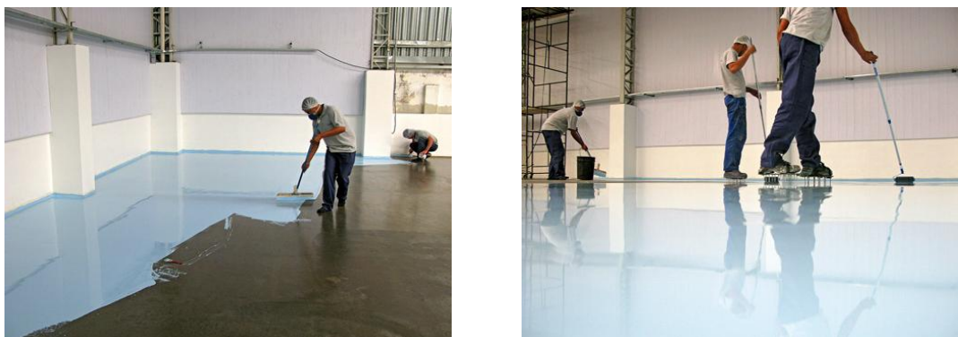
Figura 17: Aplicação do revestimento epóxi autonivelante Fonte: PINI PISOS.
