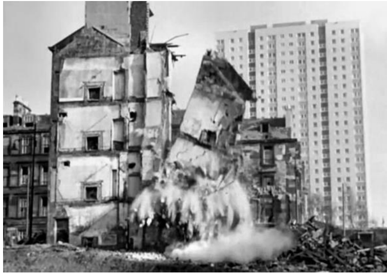
Figura 22 – Demolição de antigos edifícios e os novos blocos (atrás), déc. 1960.
