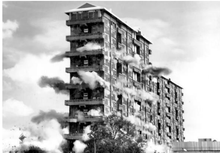
Figura 27 - Demolição dos novos blocos de Hutchesontown, 1993.
