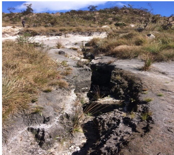
Figura 1 - Fotografia da área de estudo antes dos procedimentos de reabilitação.
