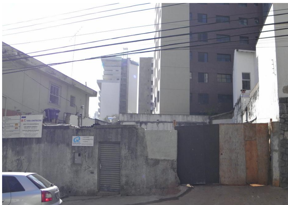
Fotografia 2 - Vista do imóvel onde está sendo edificada obra pelo Réu
