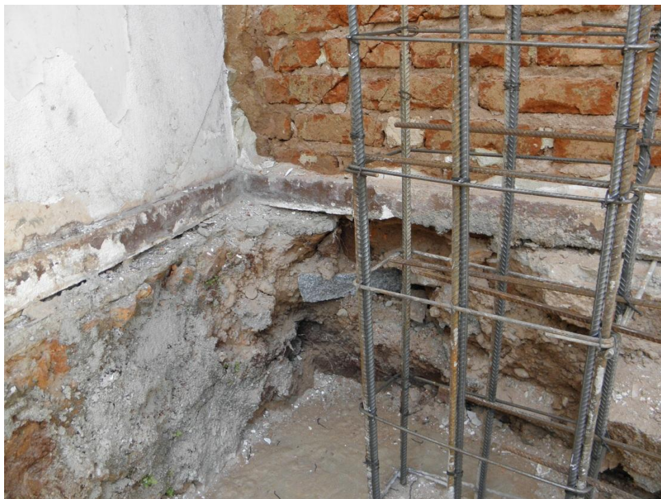
Fotografia 61 – Vista do muro de arrimo ao fundo na divisa
