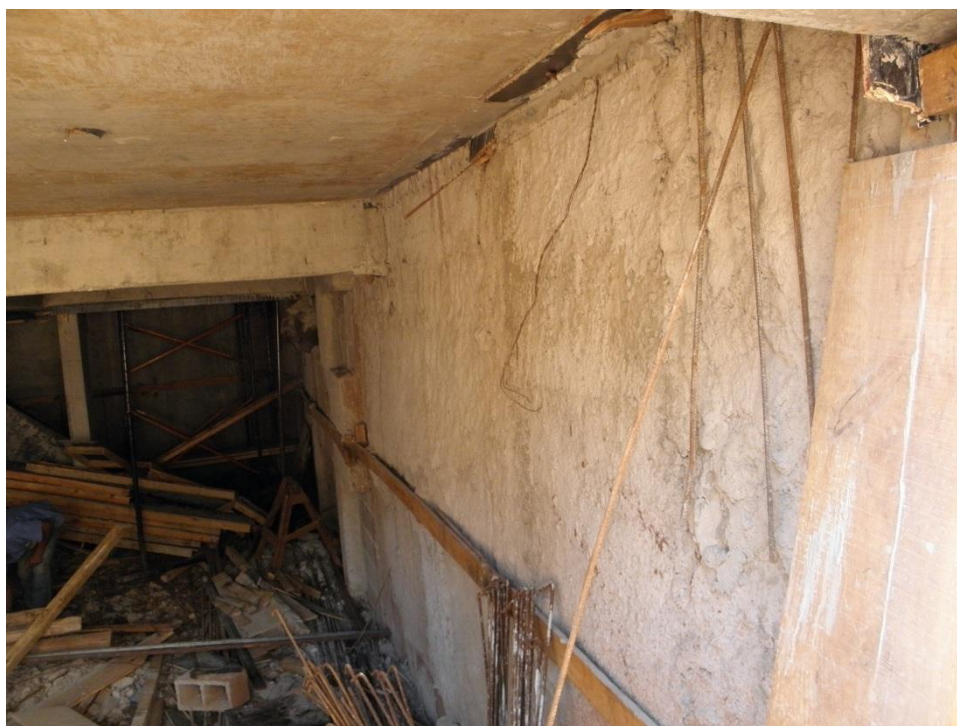
Fotografia 62 – Vista do arrimo abaixo da primeira laje
