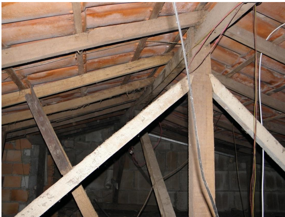
Fotografia 51 - Vista da estrutura do telhado
