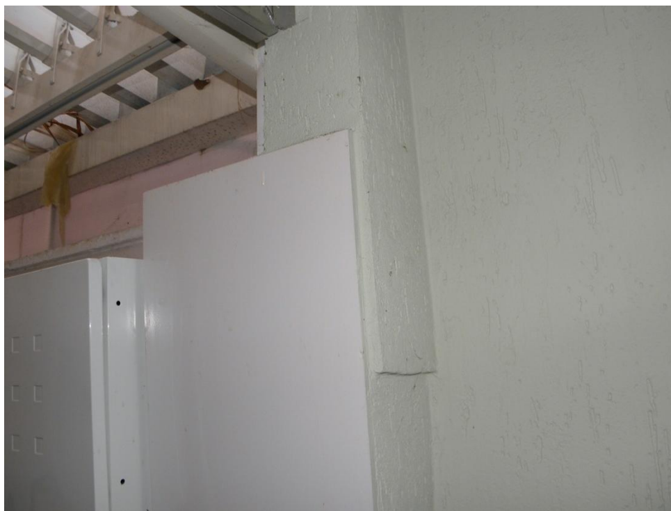
Fotografia 14 - Vista peça revestida em gesso que encamisa a tubulação de água de chuva
