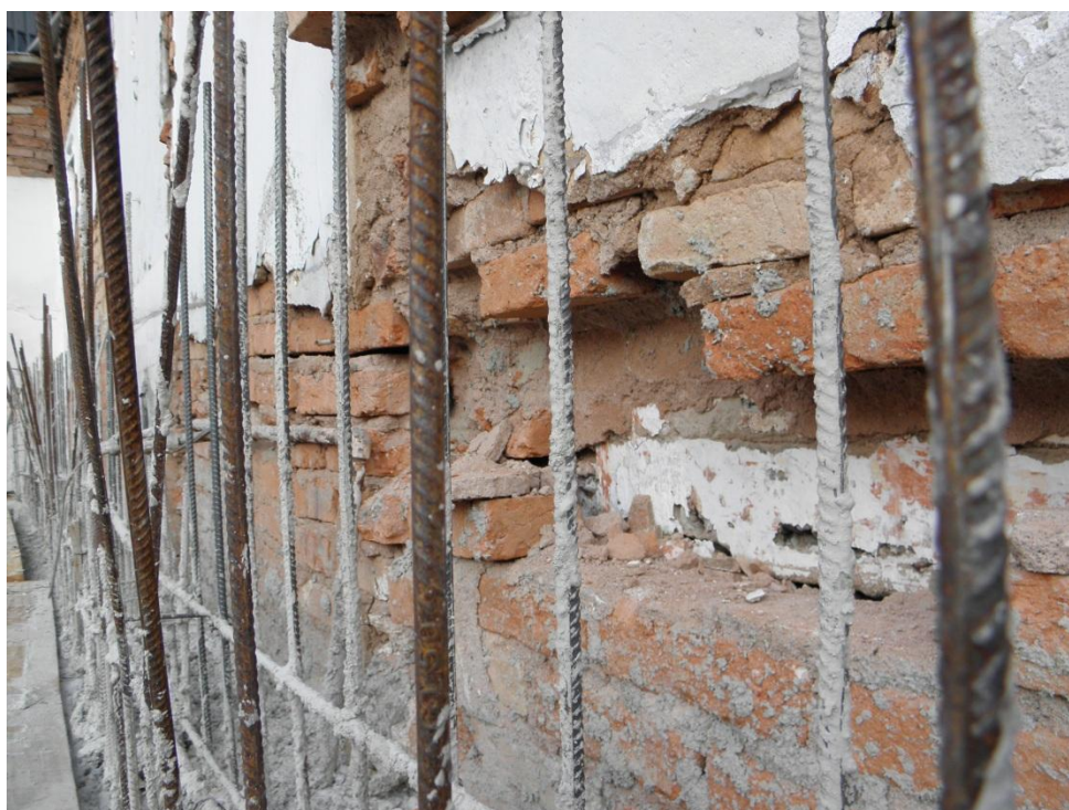
Fotografia 60 - Vista da parede interna ao muro de divisa sobre a laje
