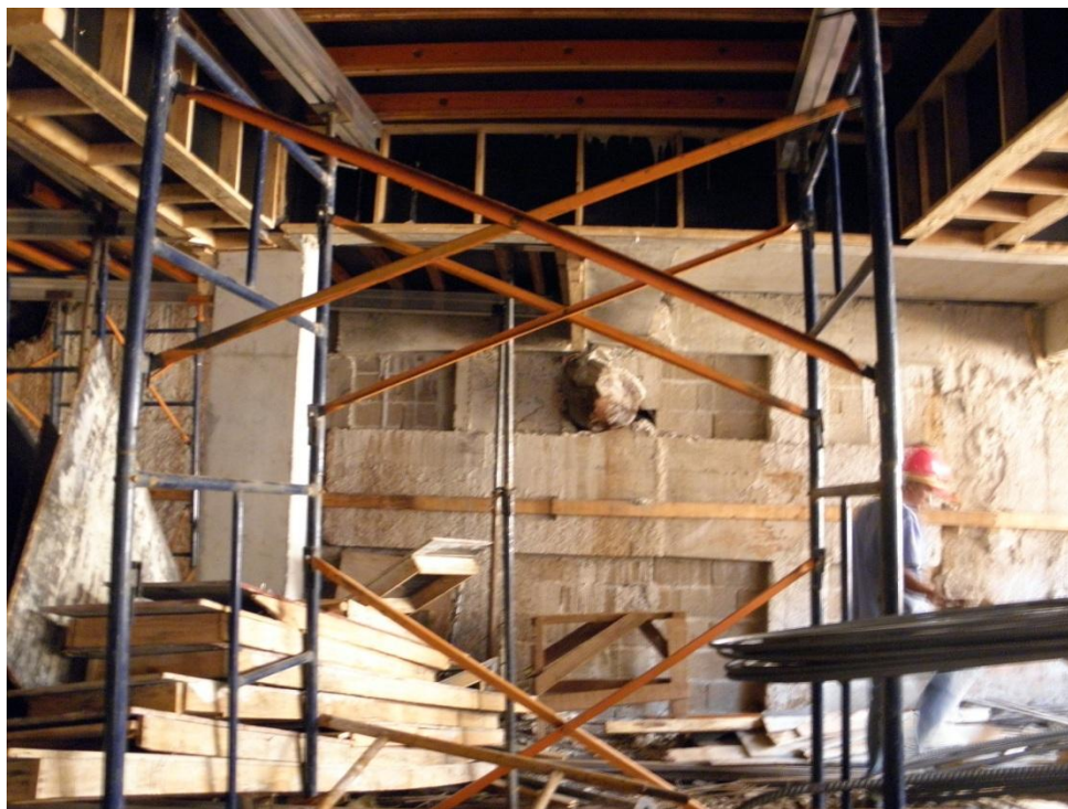
Fotografia 63 - Outra vista do arrimo abaixo da primeira laje
