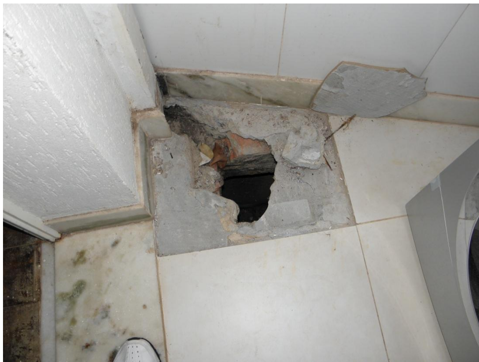
Fotografia 21 - Vista da caixa de passagem de água de chuva na área de serviço
