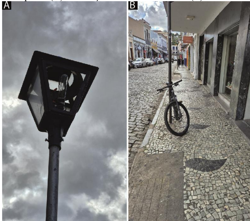
Figura 33: À esquerda (A) Iluminação danificada. À direita (B) Obstáculos na calçada.
