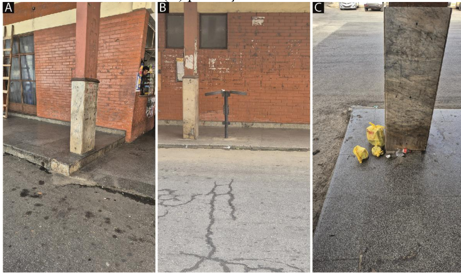
Figura 18: À esquerda (A) Sem a presença de rampa. No centro (B) Lixeira quebrada. À direita (C) presença de lixo no chão.
