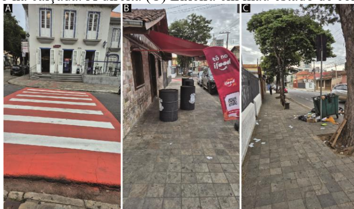
Figura 39: À esquerda (A) Faixa de travessia sem rampa de acessibilidade. No centro (B) Obstrução na calçada. À direita (C) Lixeira em mau estado de conservação.
