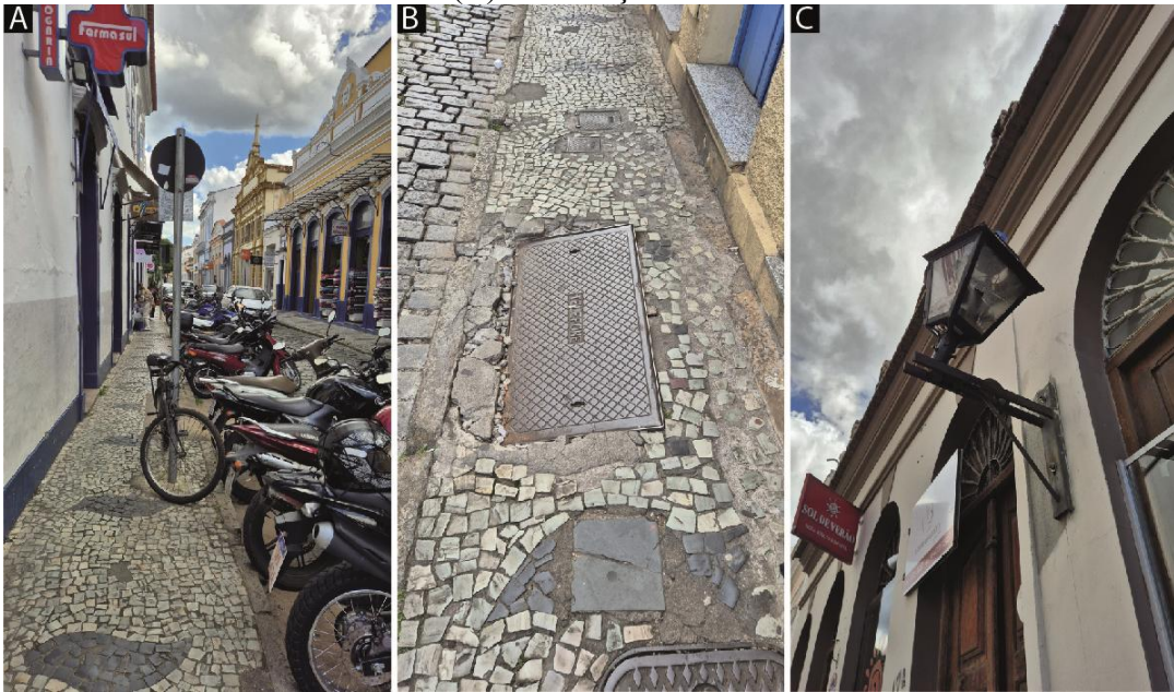
Figura 34: À esquerda (A) Obstáculos na calçada. No centro (B) Calçada com buracos. À direita (C) Iluminação danificada.
