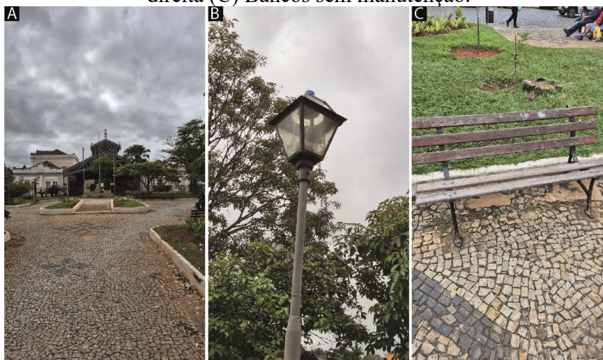
Figura 51: À esquerda (A) Vista da Praça da Estação. No centro (B) Iluminação danificada. À direita (C) Bancos sem manutenção.
