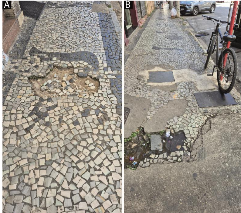
Figura 36: À esquerda (A) Calçada com buracos na Avenida Tancredo Neves. À direita (B) Buracos e obstrução na calçada.
