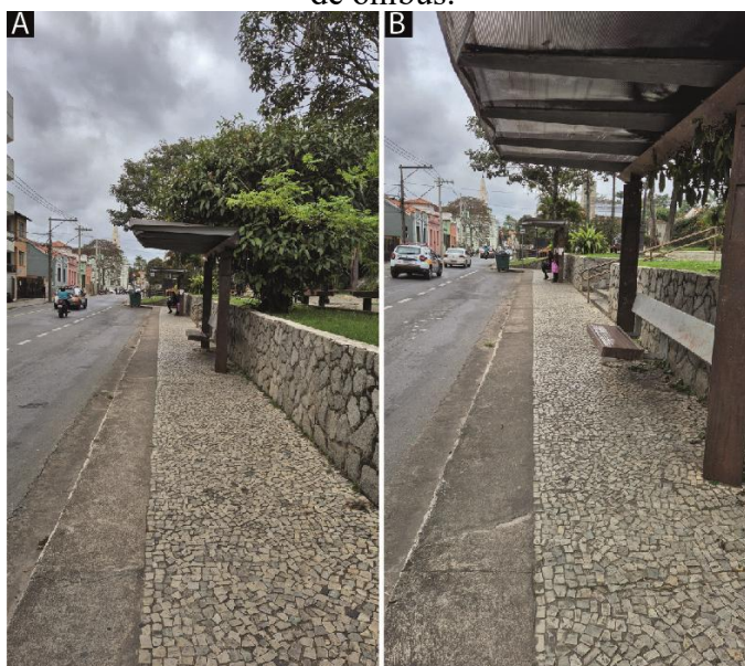
Figura 48: À esquerda (A) Vista para o ponto de ônibus. À direita (B) Infraestrutura do ponto de ônibus.
