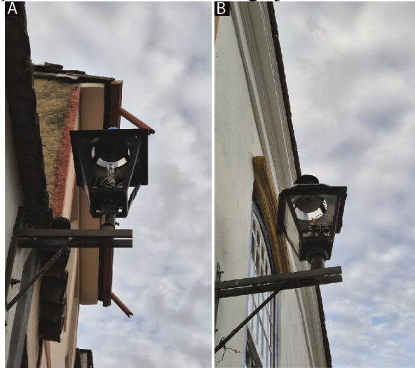
Figura 22: À esquerda (A) Iluminação danificada próxima ao Mercado Municipal. À direita (B) Iluminação danificada em frente à Igreja Nossa Senhora do Carmo.
