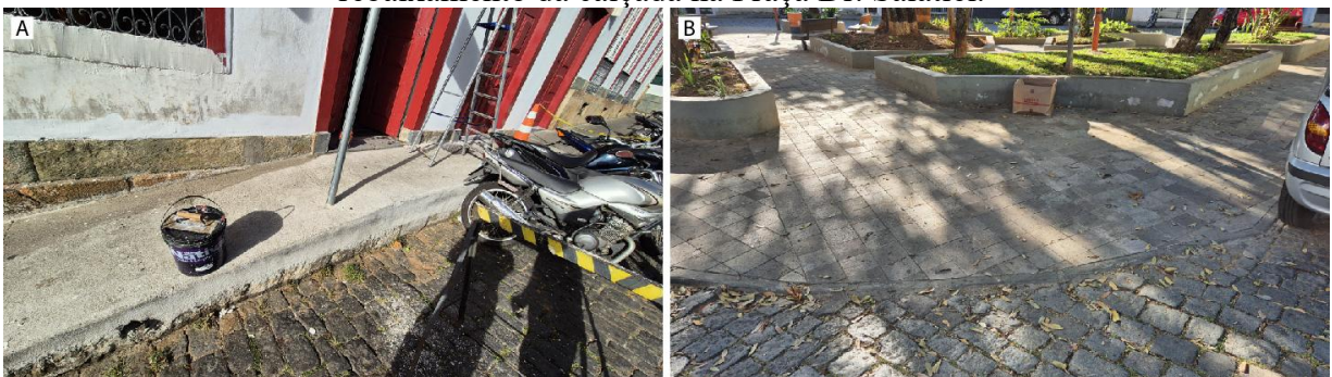
Figura 6: À esquerda (A) Rampa de acesso ao Centro Cultural UFSJ. À direita (B) rebaixamento da calçada na Praça Dr. Salatiel.
