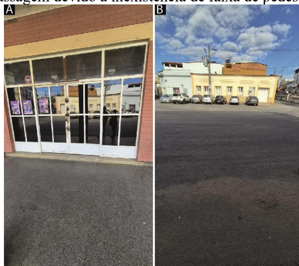
Figura 19: À esquerda (A) Antigo Posto Policial desativado. À direita (B) Área de difícil passagem devido a inexistência de faixa de pedestre.
