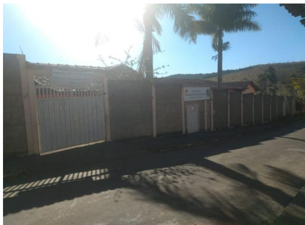
Figura 1: Fachada da escola
