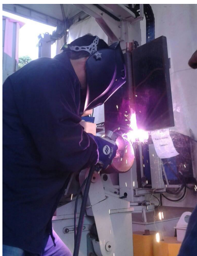
Figura 11 - Posição de soldagem Vertical Ascendente -3G
