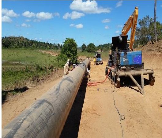
Figura 01: Desfile e acoplamento dos tubos
