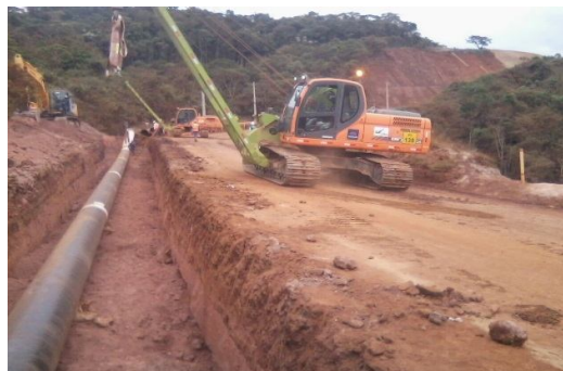
Figura 04: Rebaixamento dos tubos soldados
