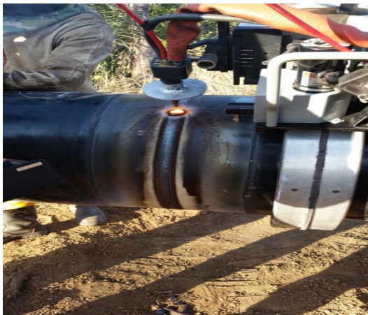
Figura 02: Soldagem FCAW Orbital: Pipe Kat PK200 / Pk500 Figura 03: Excelente acabamento da solda FCAW
