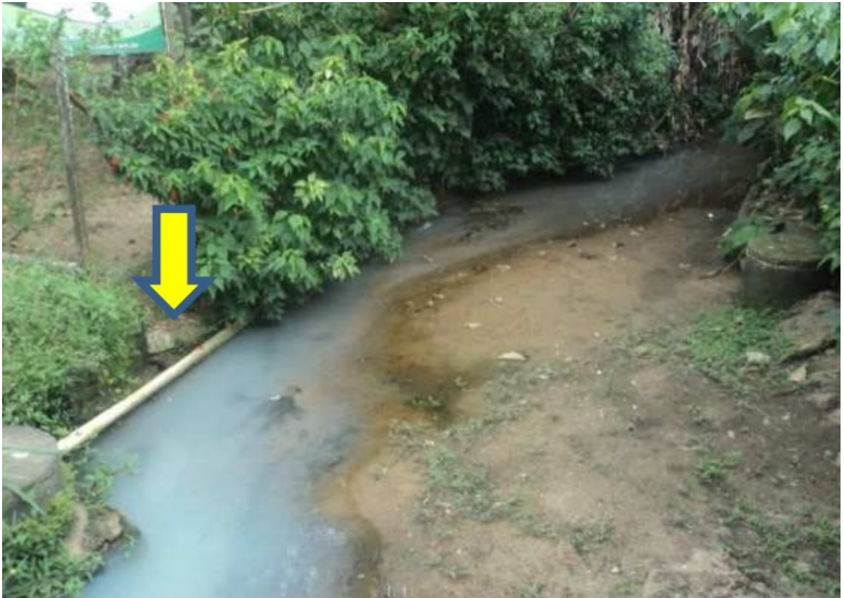
Figura 48 – Poço de visita e tubulação de esgoto em trecho hídrico, Vila do Abraão, Ilha Grande, Rio de Janeiro, Brasil
