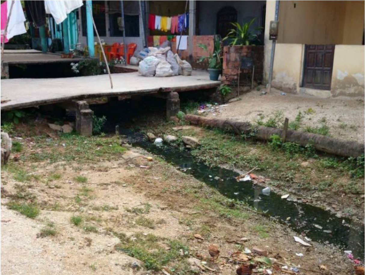
Figura 49 – Canal aberto para o transporte de águas pluviais e esgoto na região de Santana, Ilha de Maré, Salvador, Bahia, Brasil
