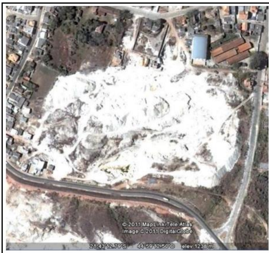
Figura 1 - Empreendimento Carlos Veloso FI Fonte: FUNDAÇÃO ESTADUAL DO MEIO AMBIENTE, 2011, p. 43.
