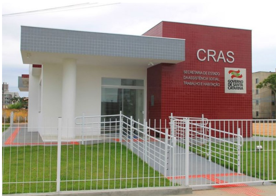
Figura 10 - Fachada principal do CRAS em Biguaçu, SC
