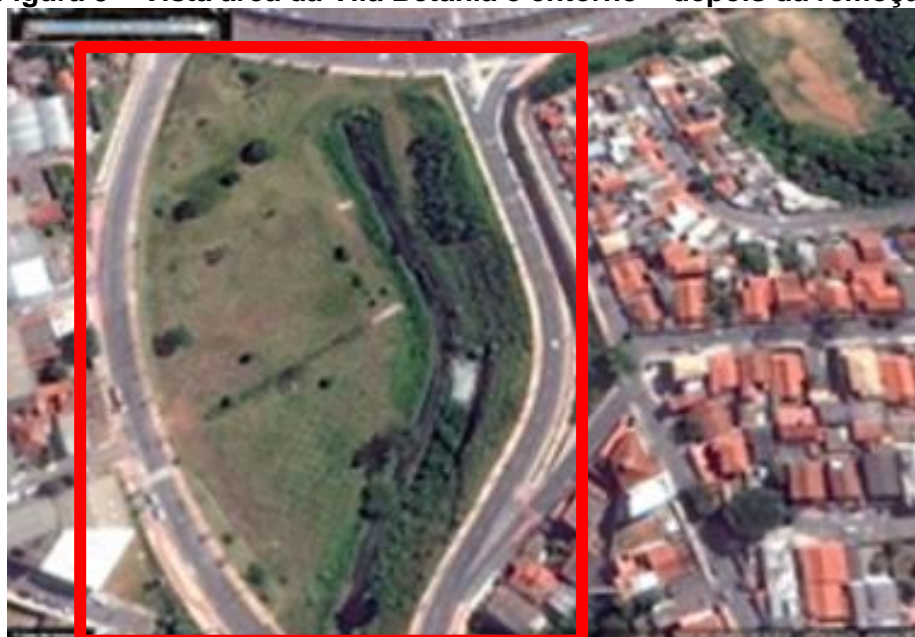
Figura 5 – Vista área da Vila Betânia e entorno – depois da remoção
