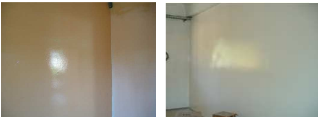
Figura 4.10: Pintura das paredes com material selante e tinta epóxi.
