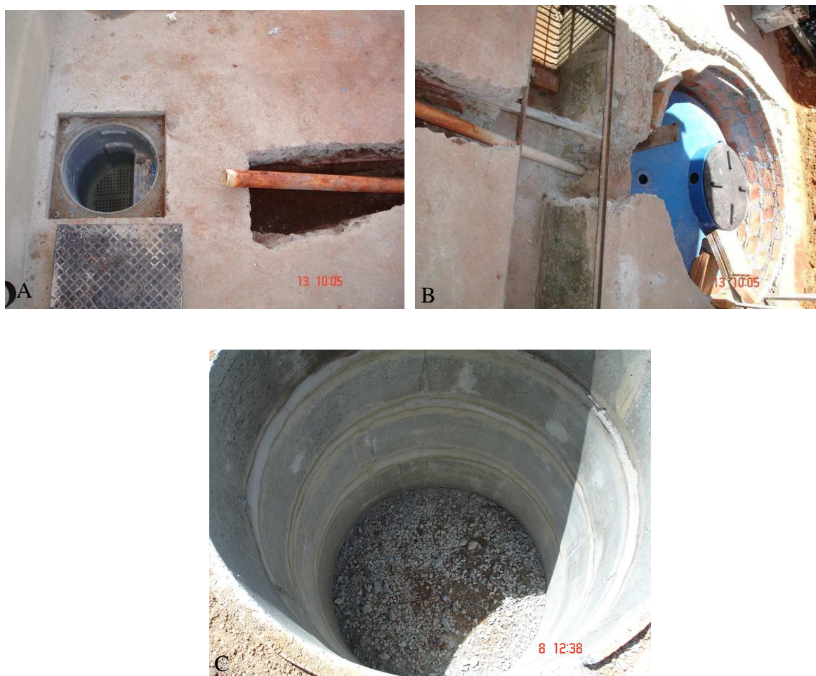
Figura 4.14: A: primeiro tratamento com cloro sólido. B: segundo tratamento com cloro sólido. C: Caixa de infiltração.
